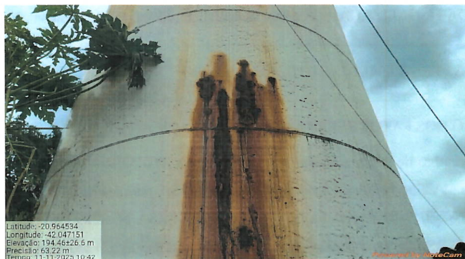
Foto 02 – Infiltração.
