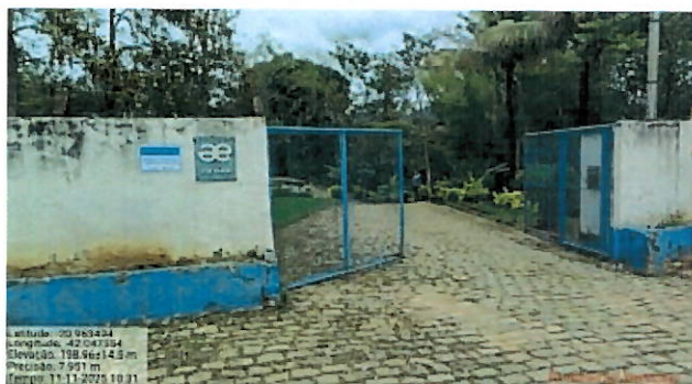
Foto 05 - entrada da ETA.
