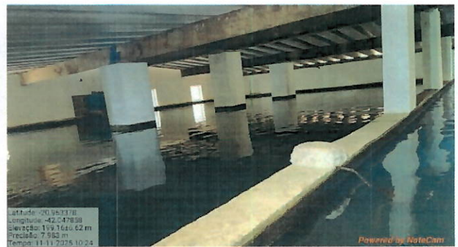
Foto 21 - interior do reservatório.
