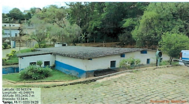
Foto 20 - exterior do reservatório.
