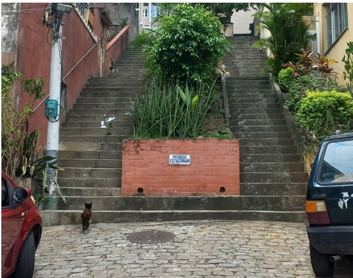
Figura 2: imóvel da reclamante na parte superior da escada
