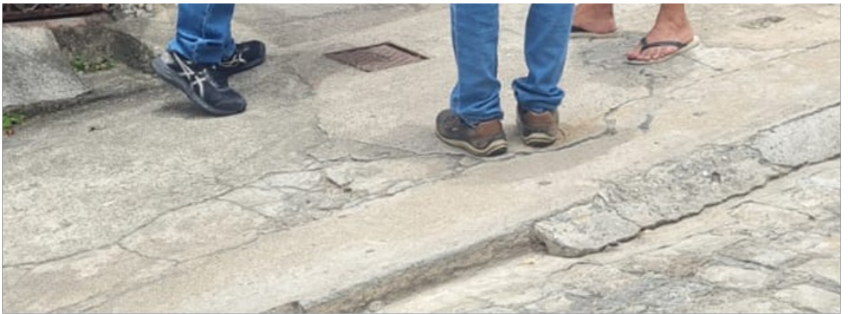
Figura 3: Entrada do reservatório inferior
