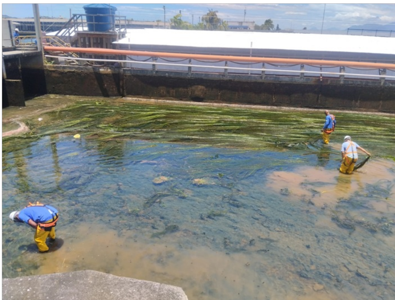
Foto 07 – Equipe retirando vegetação do tanque de tranquilização.
