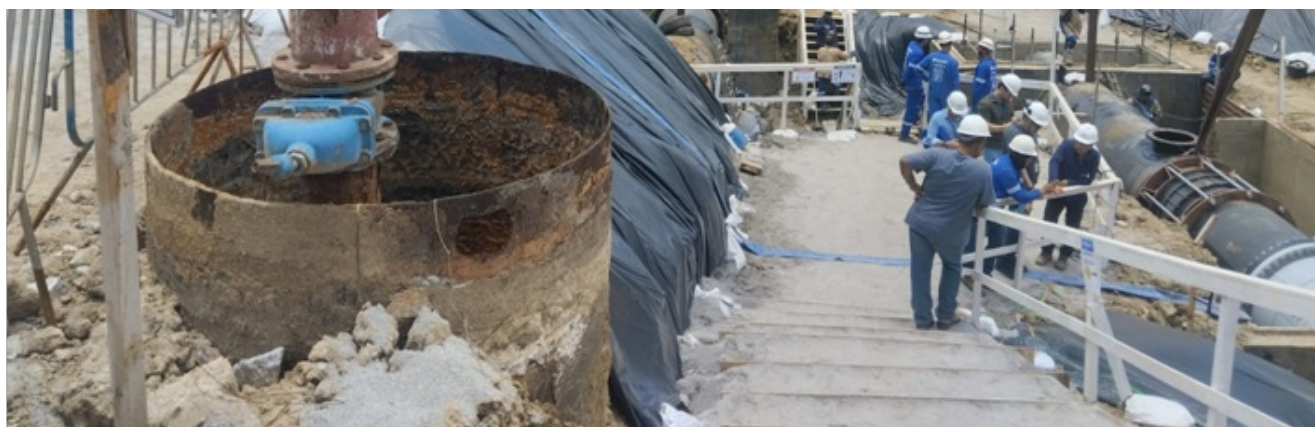
Foto 03 –Macromedidor 1ª linha e 2ª linha.
