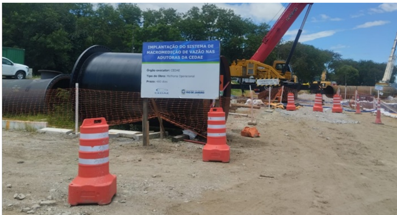
Foto 01- Placa de identificação das obras.
