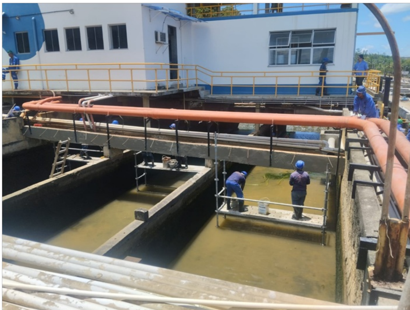
Foto 08 – Recuperação estrutural na ETA Guandu.
