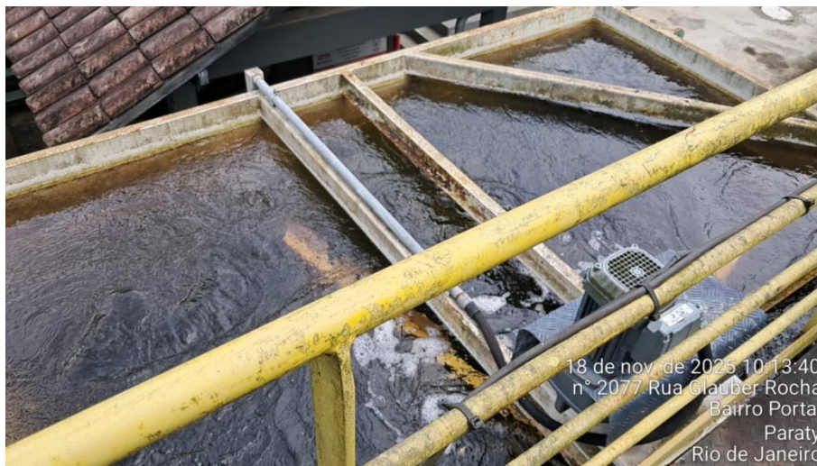
Foto 04 - Floculador mecânico
