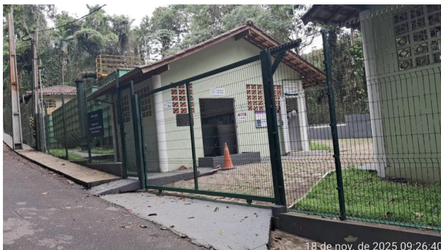
Foto 01 - Entrada da ETA
