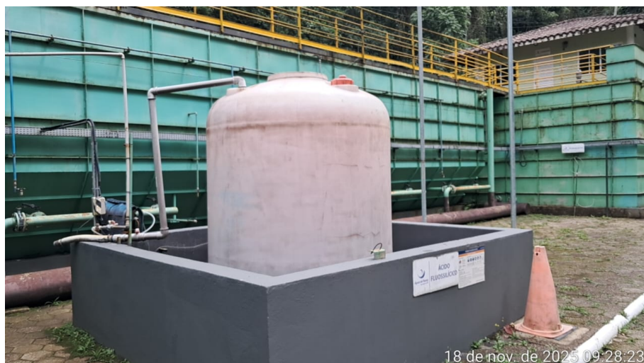
Foto 09 - Armazenamento de ácido fluossilíco;
