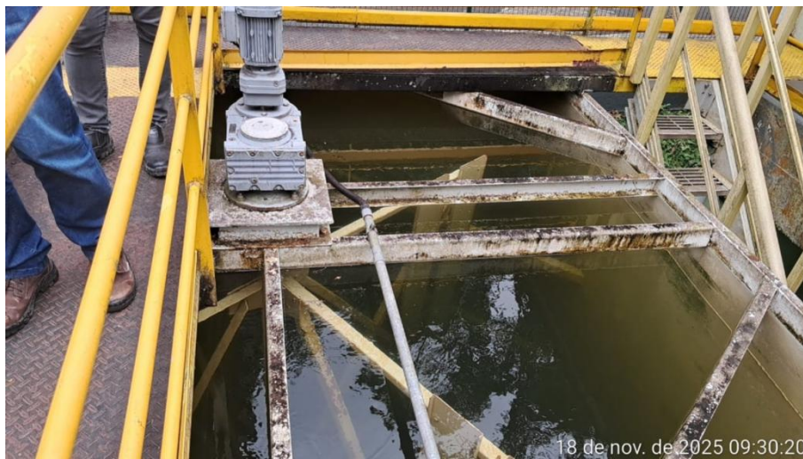
Foto 04 - Flocculadores mecânicos
