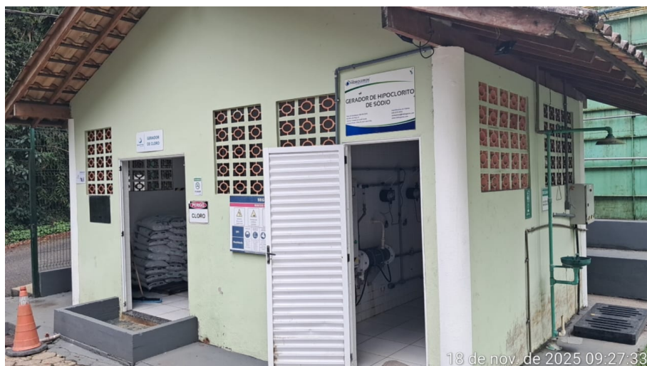
Foto 08 - Abrigo do gerador de hipoclorito
