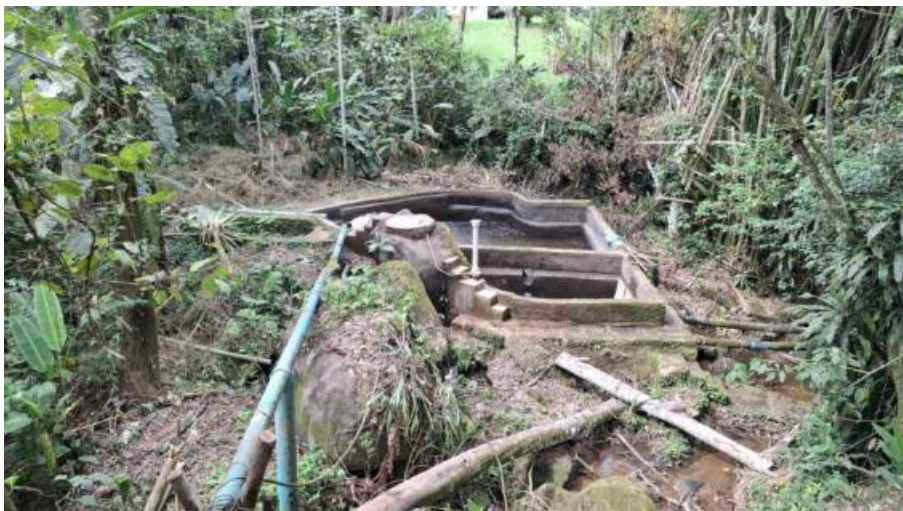
Foto 01 - Vista da estrutura da captação
