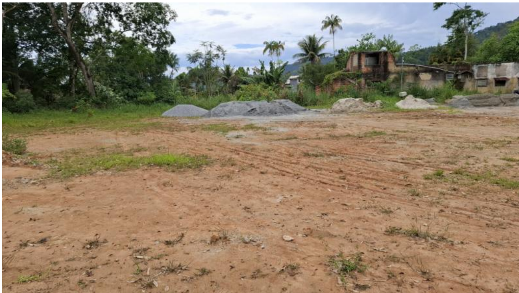
Foto 02 - Terreno e materias para obra
