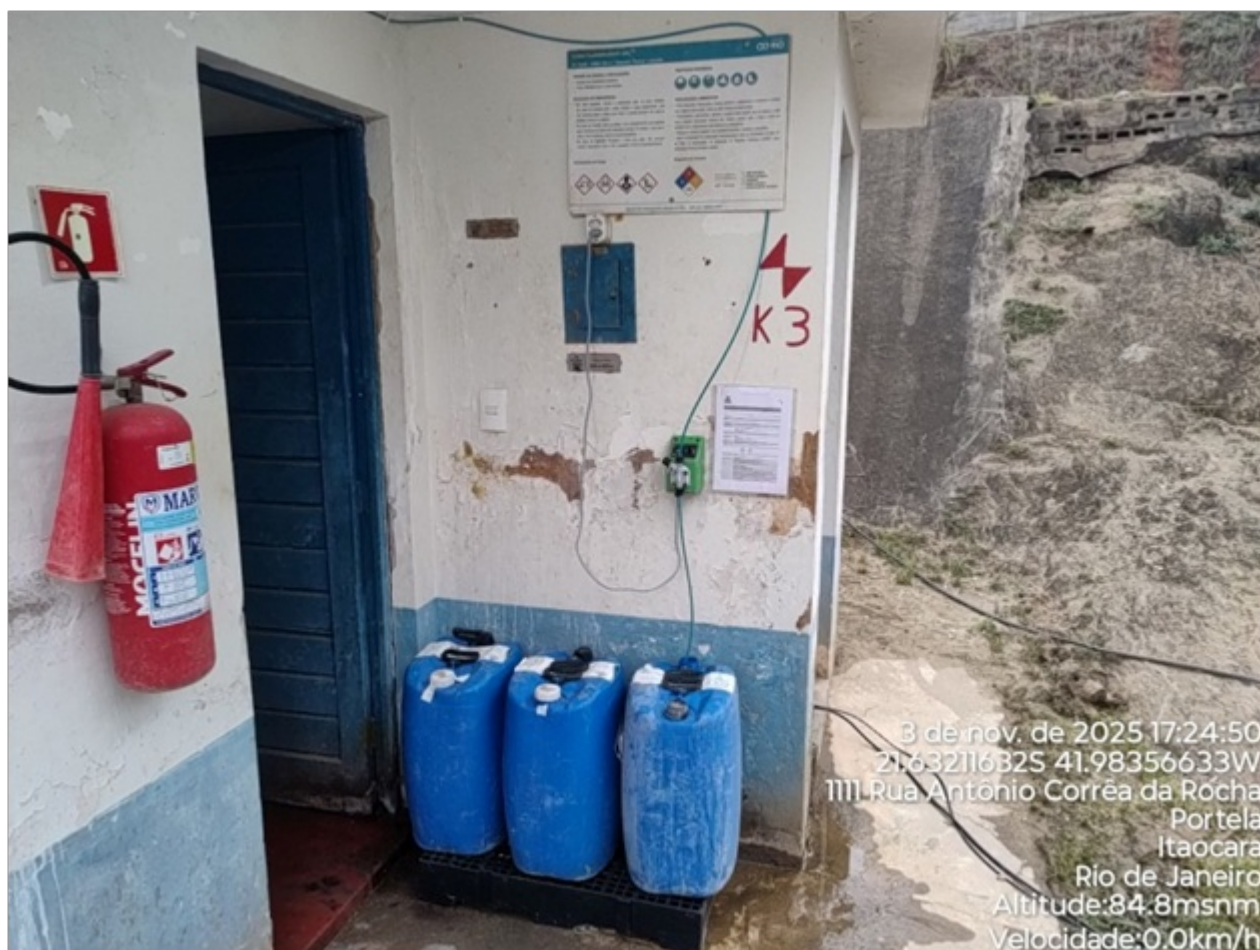
Foto 13: Dosador de Ácido fluossilícico.
