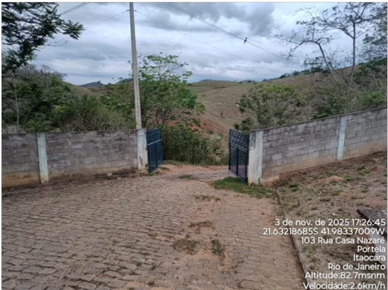
Foto 01: Acesso a ETA.
