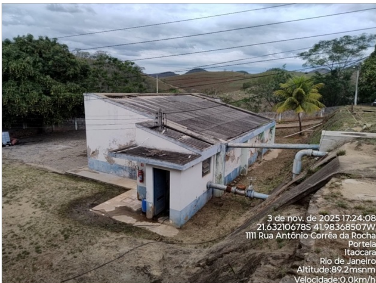
Foto 19: EEAT e Reservatório da ETA.
