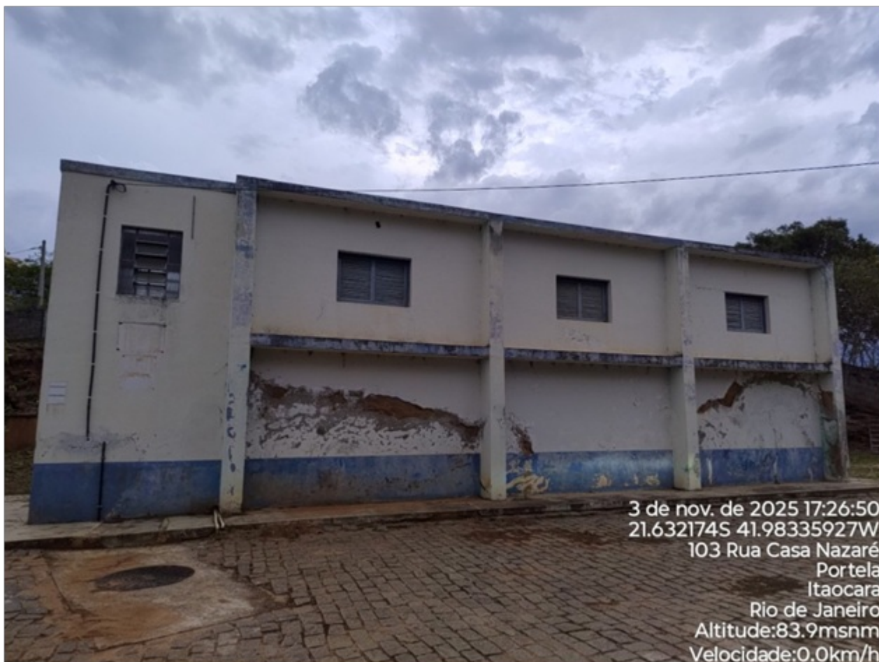
Foto 21: Reservatório da ETA.
