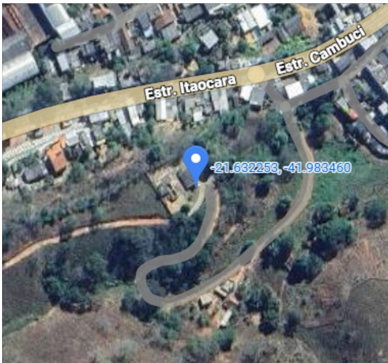
Imagem 01: Localização da ETA.
