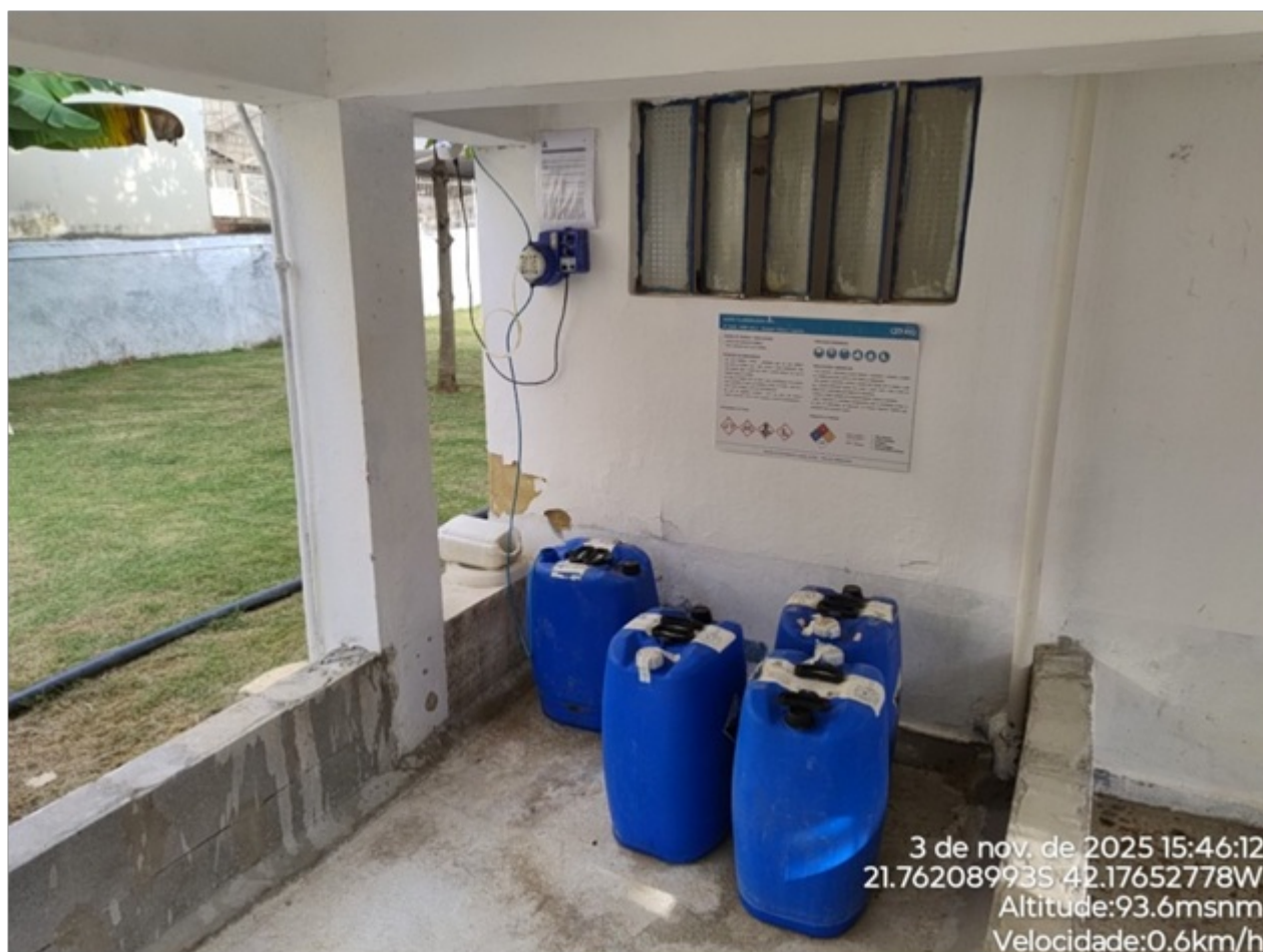
Foto 15: Dosador de Sulfato de alumínio (Agente coagulante).
