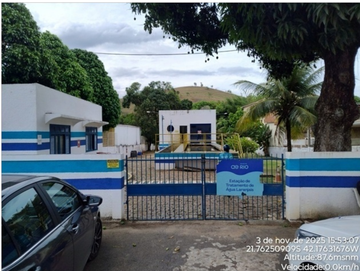
Foto 01: Entrada da ETA.
