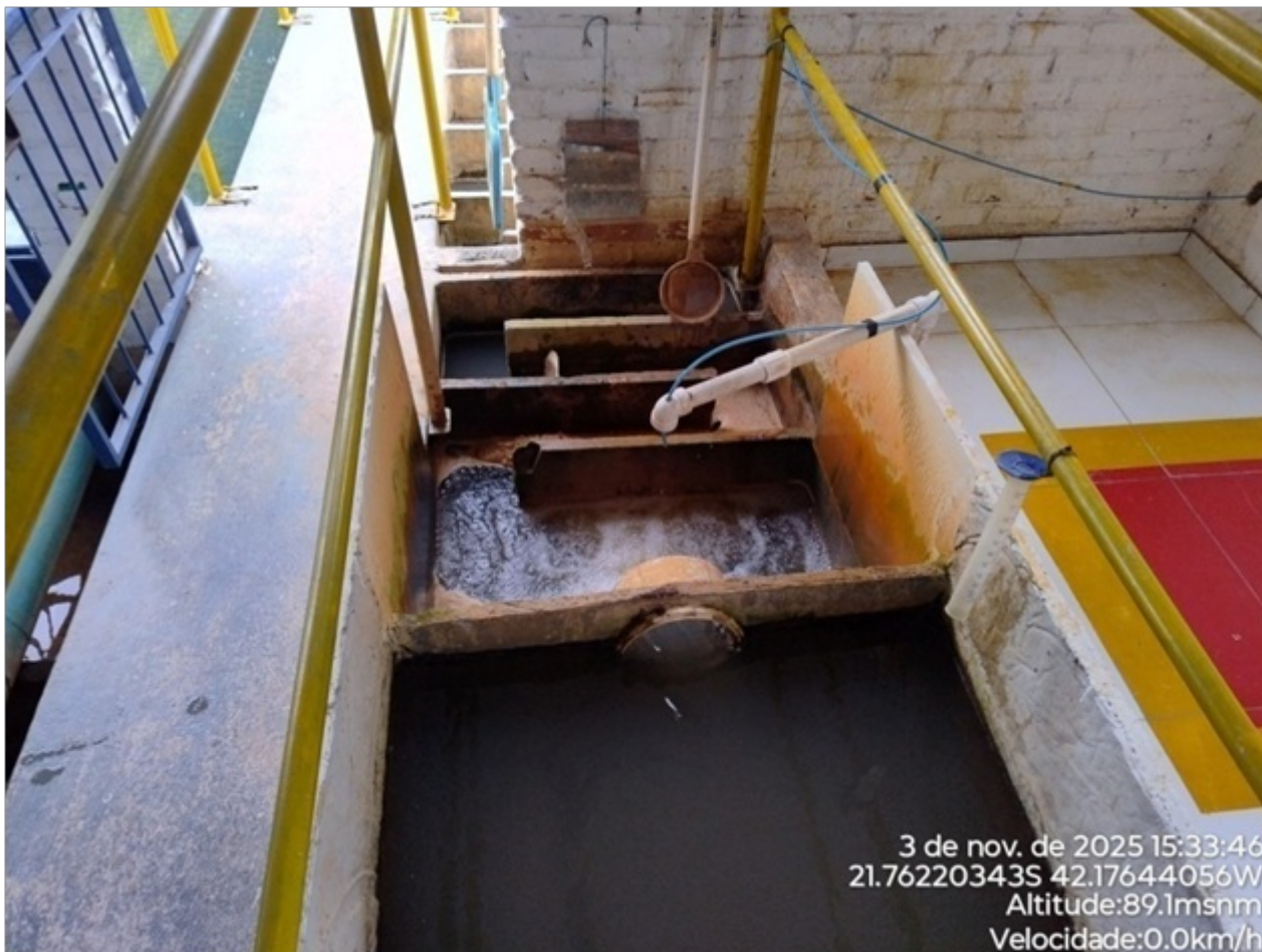
Foto 07: Chegada água bruta e aplicação do agente coagulante.
