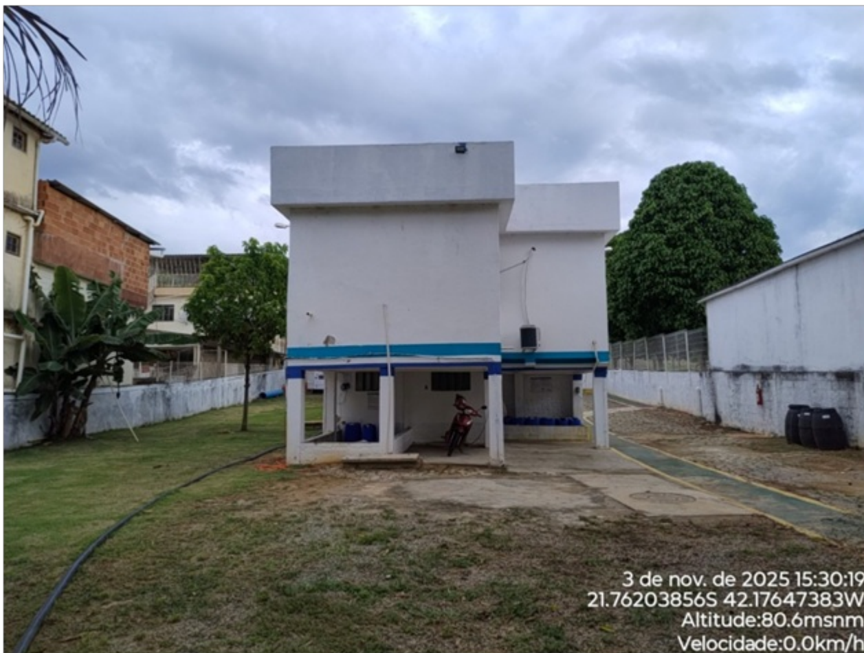
Foto 06: Vista dos fundos da ETA.
