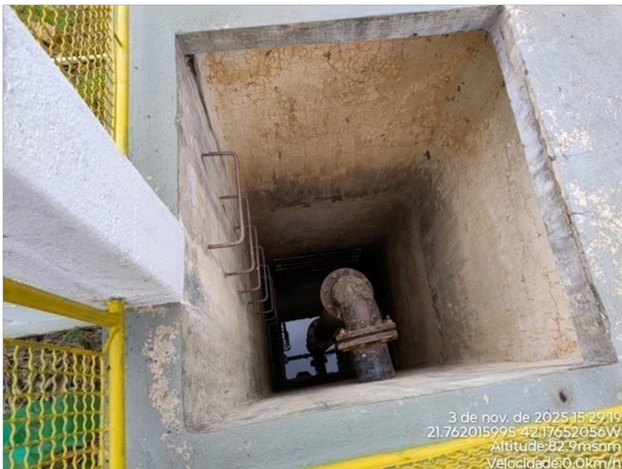
Foto 04: Poço de captação de água bruta.
