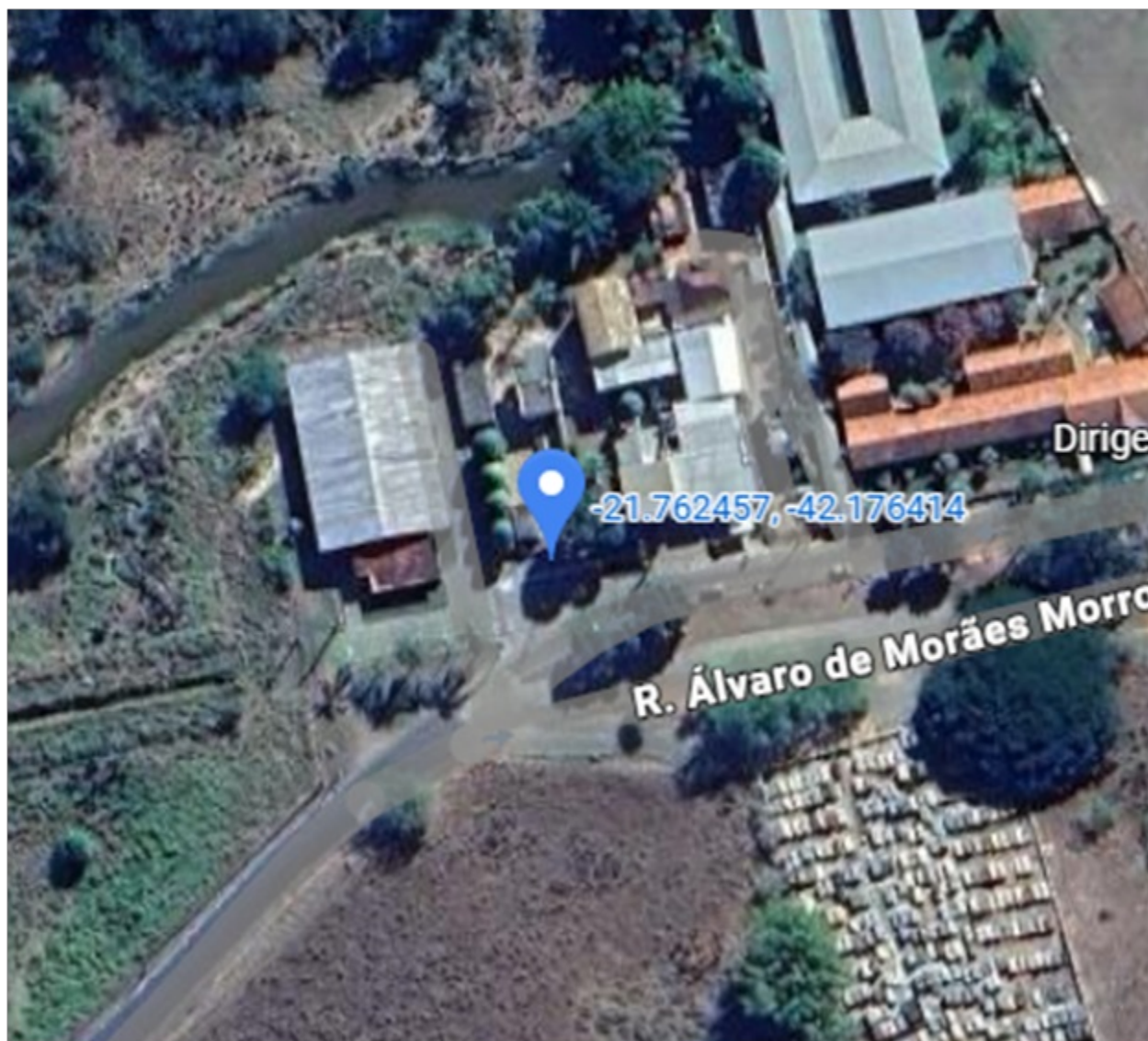
Imagem 01: Localização da ETA.
