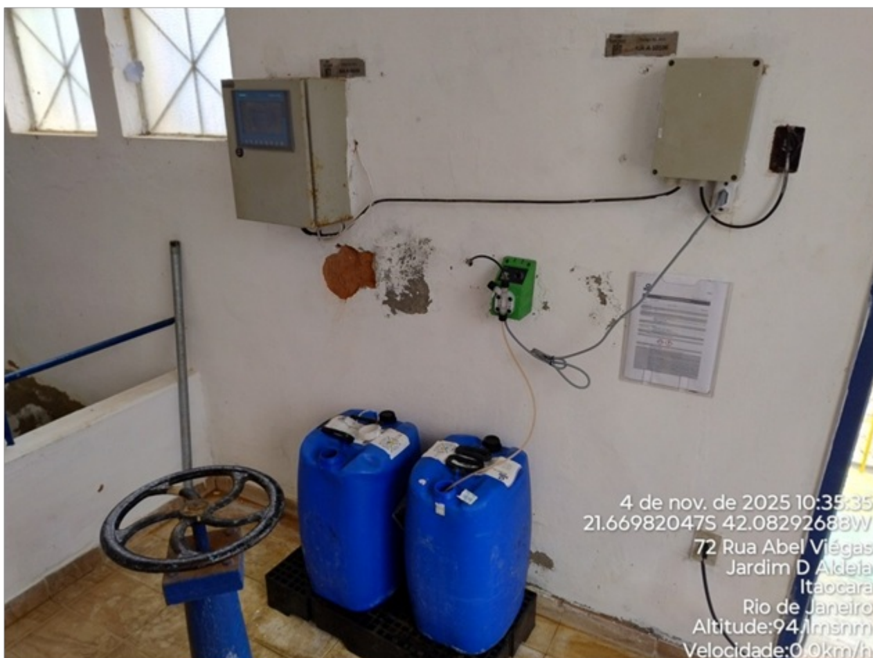
Foto 11: Dosador de Ácido fluossilícico.
