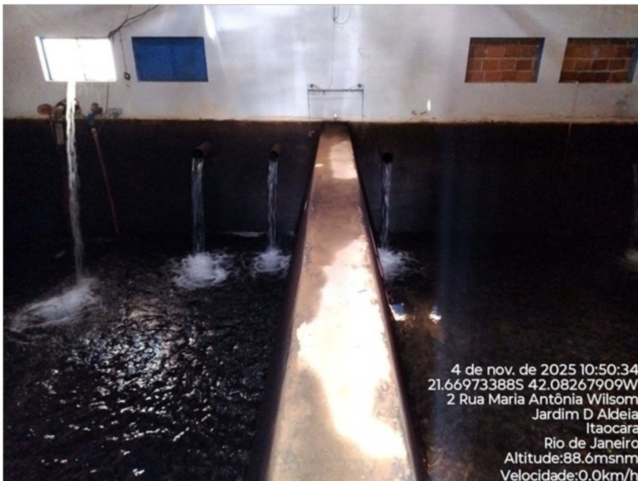
Foto 19: Reservatório da ETA.
