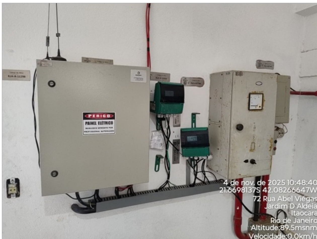
Foto 18: Painel de comando da EEAT e macromedidor.
