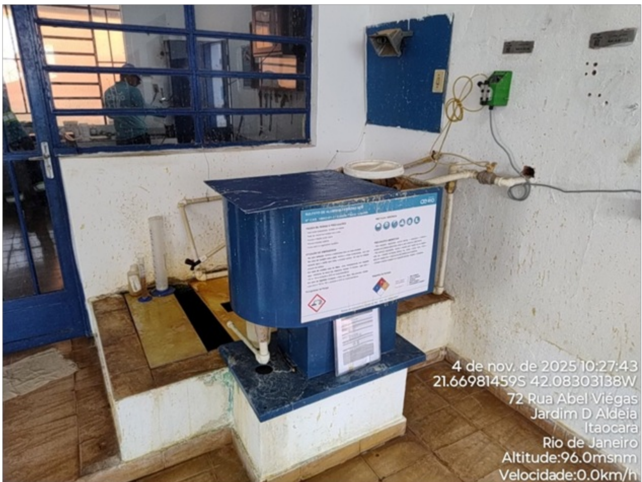
Foto 03: Aplicação do Sulfato de alumínio (agente coagulante).
