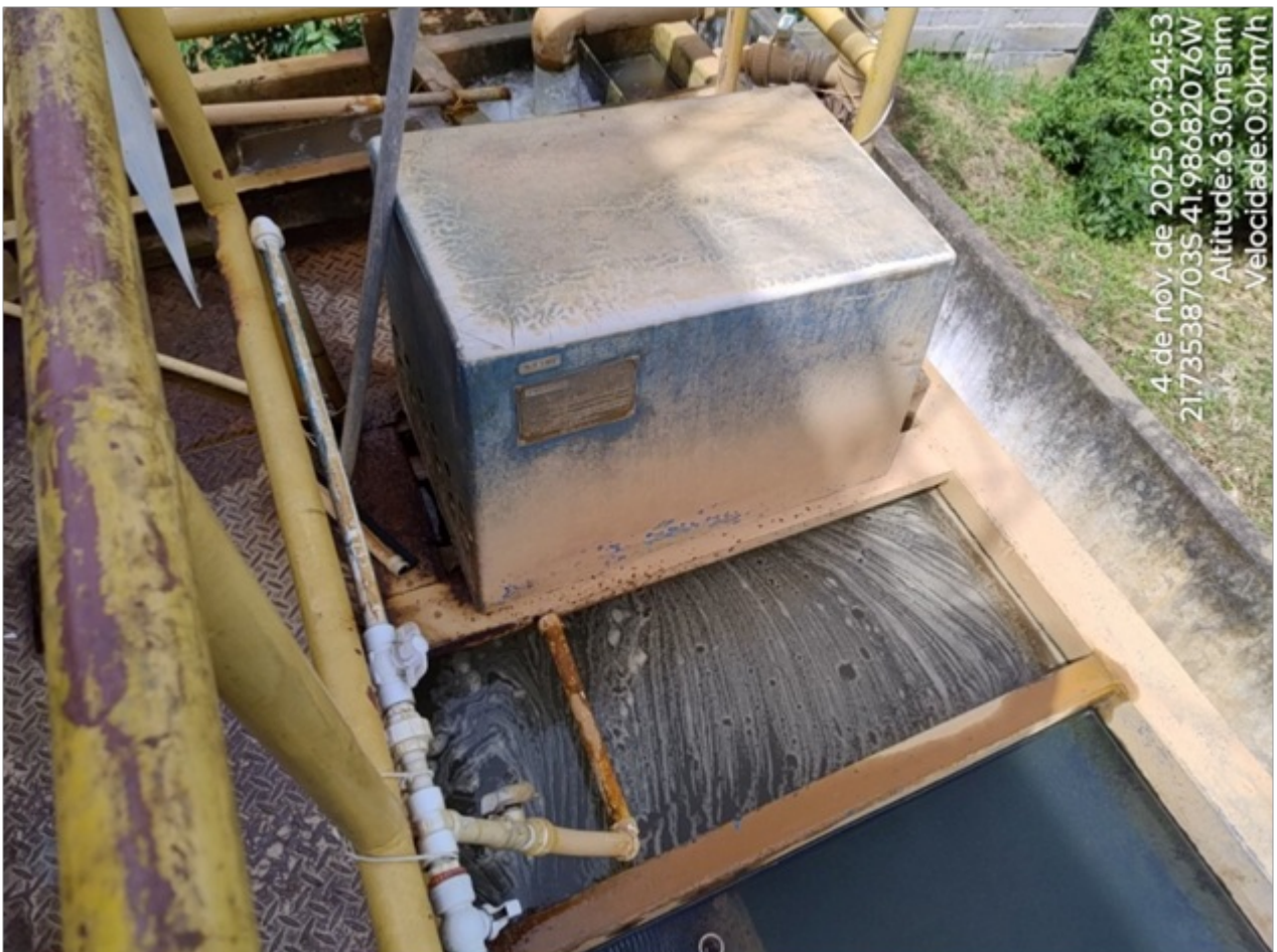
Foto 07: Chegada da água bruta e aplicação do agente coagulante.
