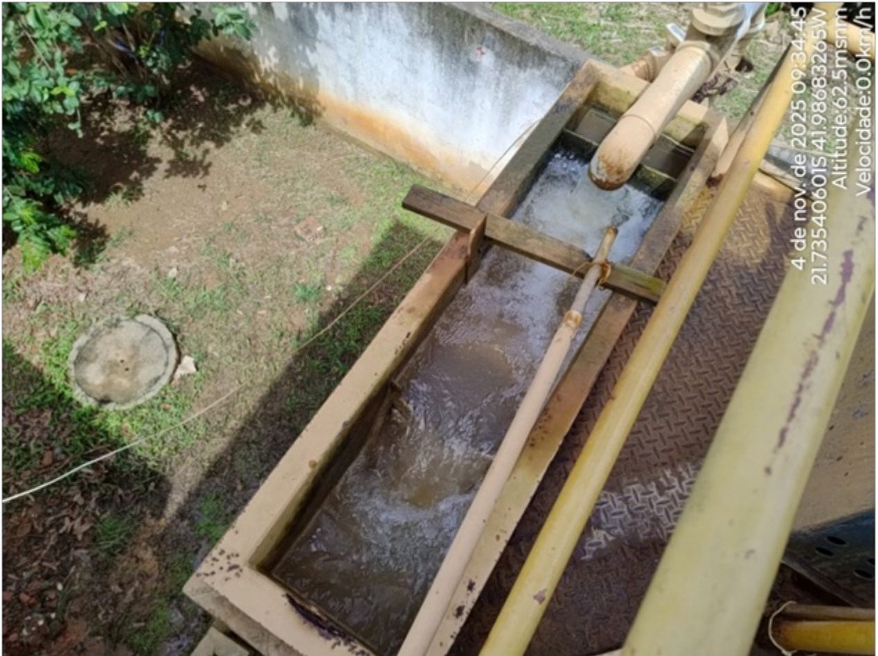
Foto 07: Chegada da água bruta e aplicação do agente coagulante.
