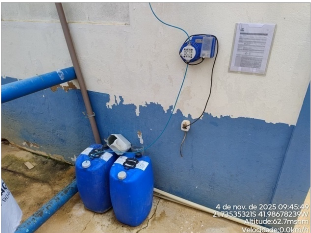
Foto 15: Dosador de Ácido fluossilícico.
