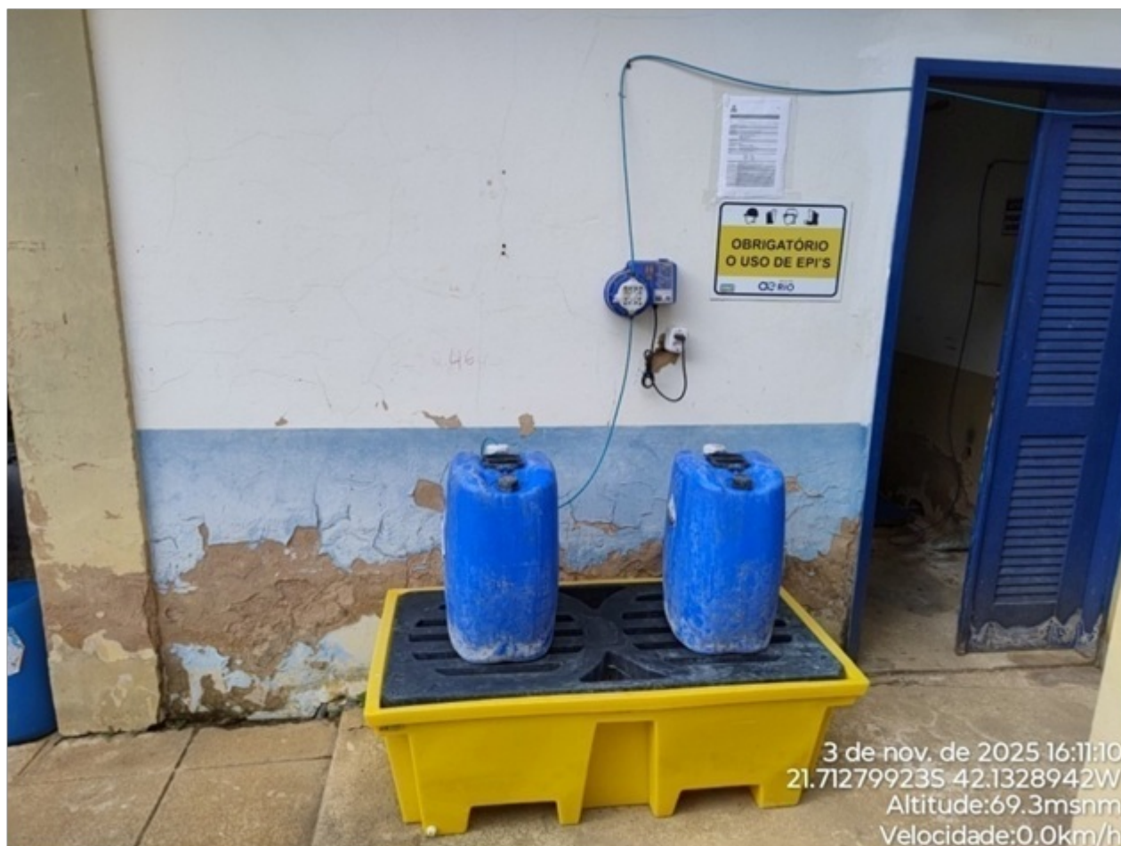
Foto 13: Dosador de Ácido fluossilícico.
