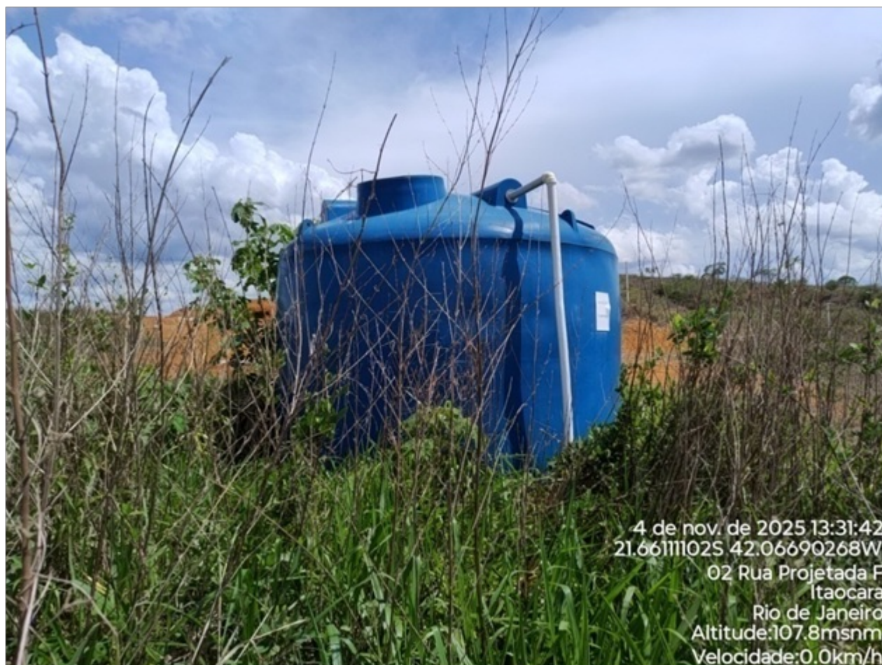
Foto 02: Vista do reservatório.
