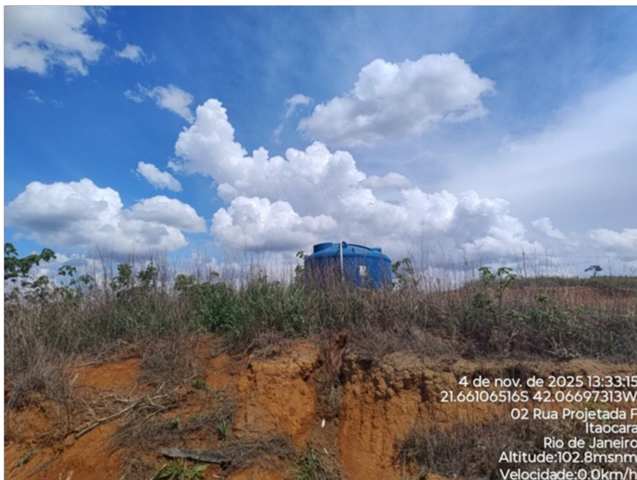
Foto 01: Vista do reservatório.
