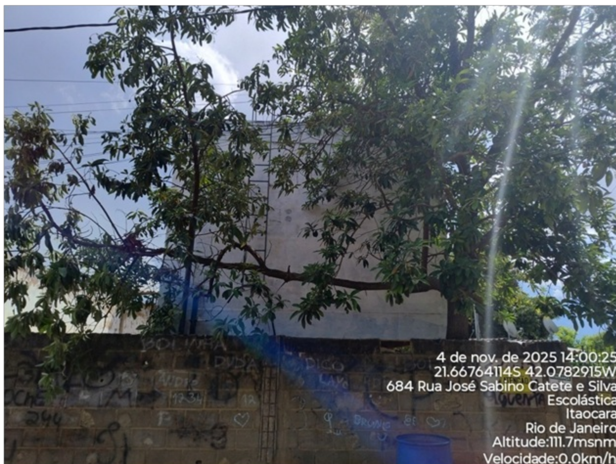
Foto 04: Vista parcial do reservatório.
