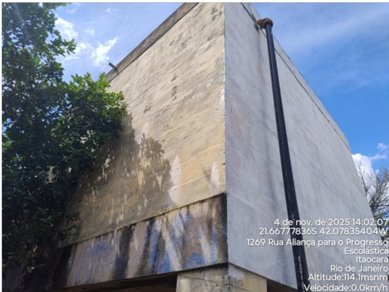
Foto 08: Vista lateral do reasevatório.
