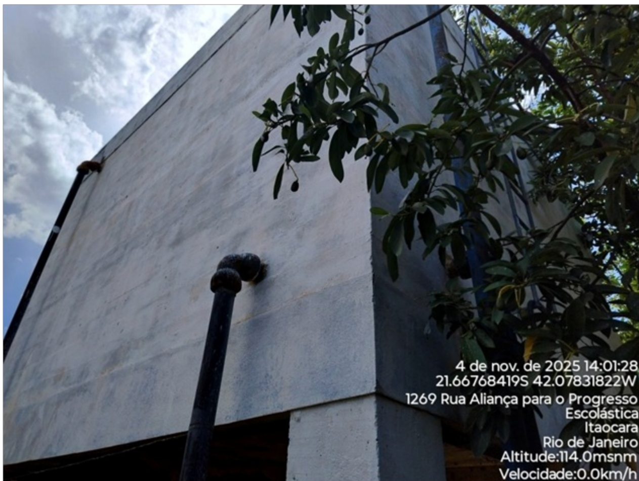
Foto 07: Vista parcial do reservatório.
