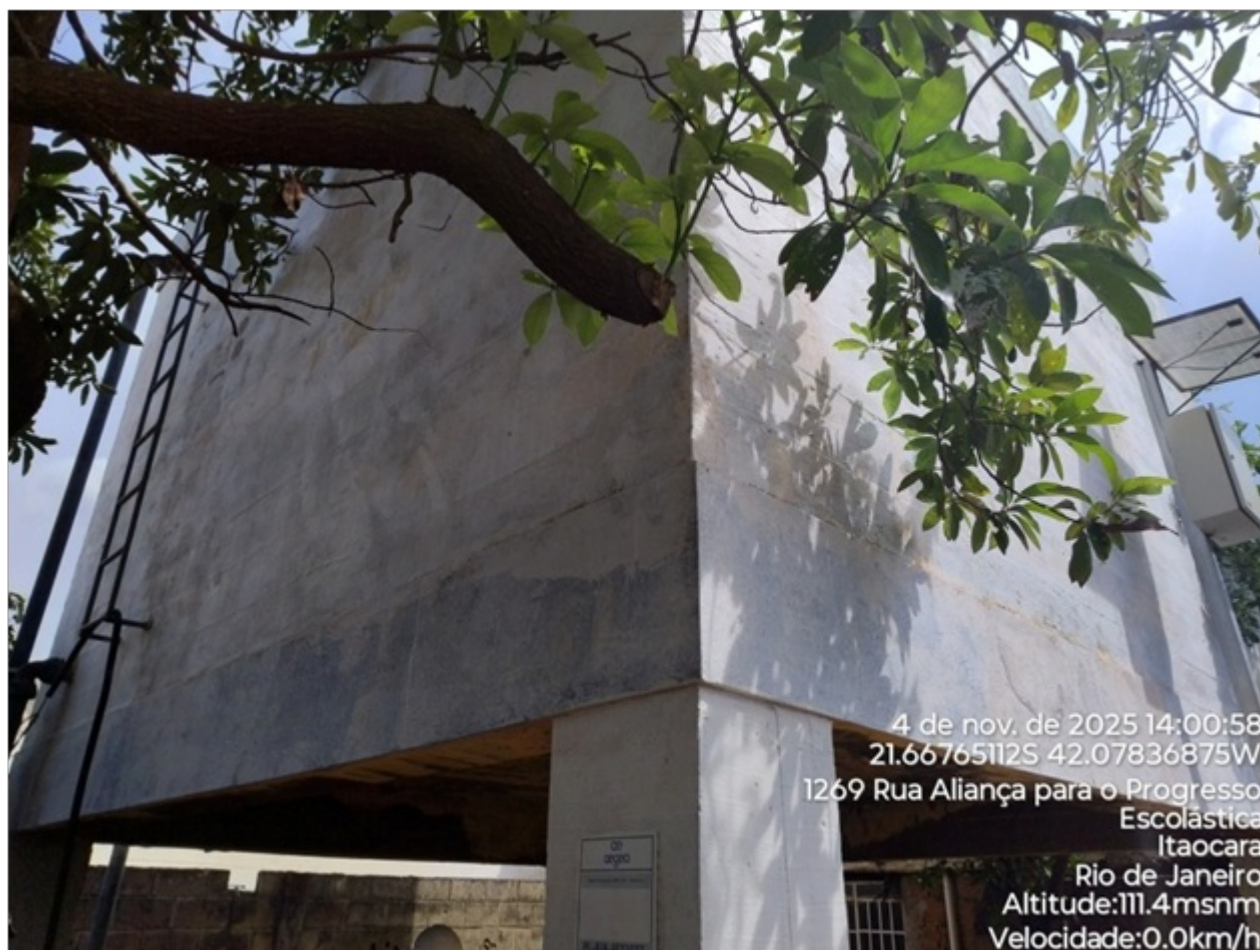
Foto 05: Vista lateral do reservatório.
