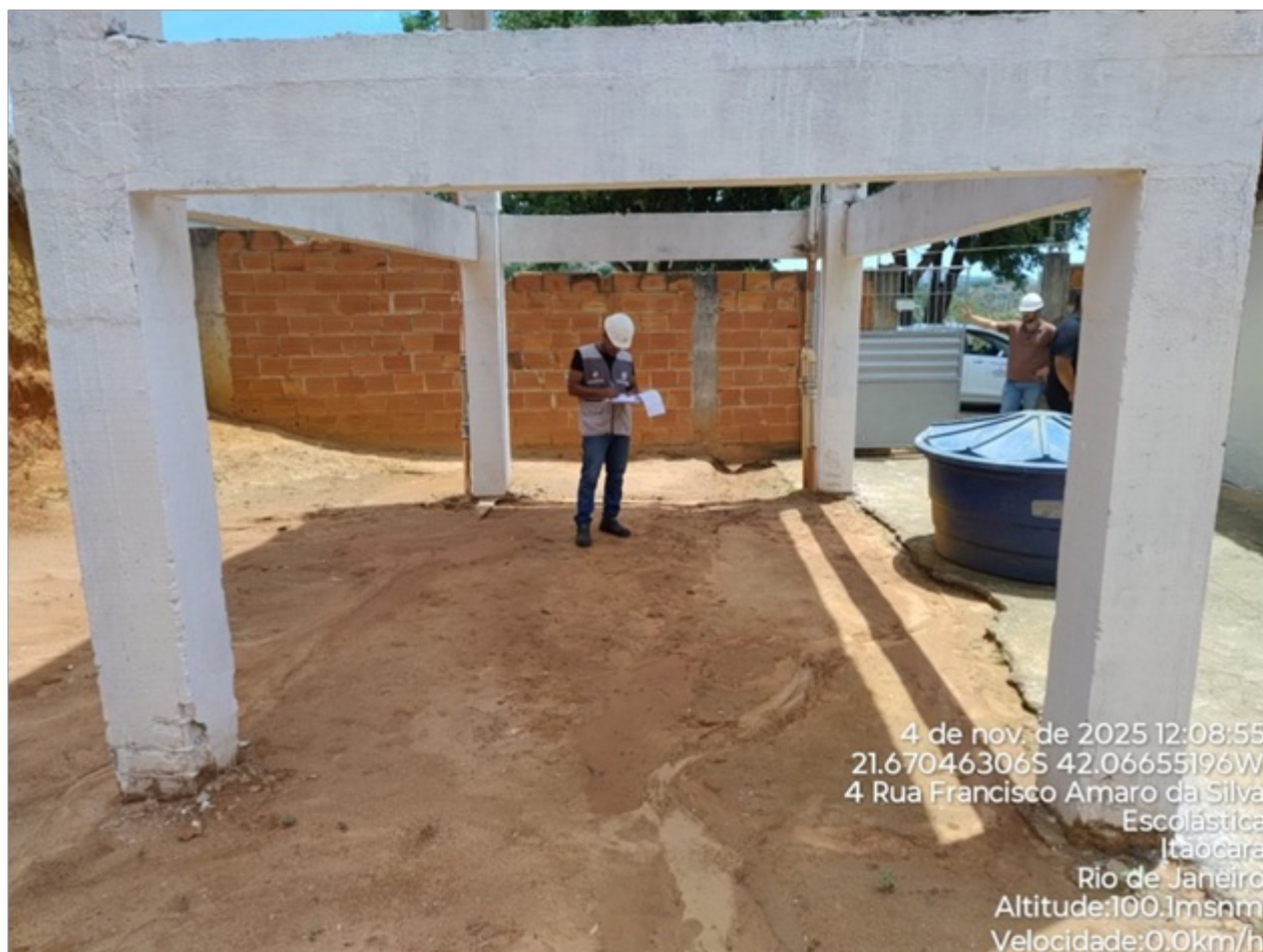
Foto 06: Pilares de apoio do reservatório.
