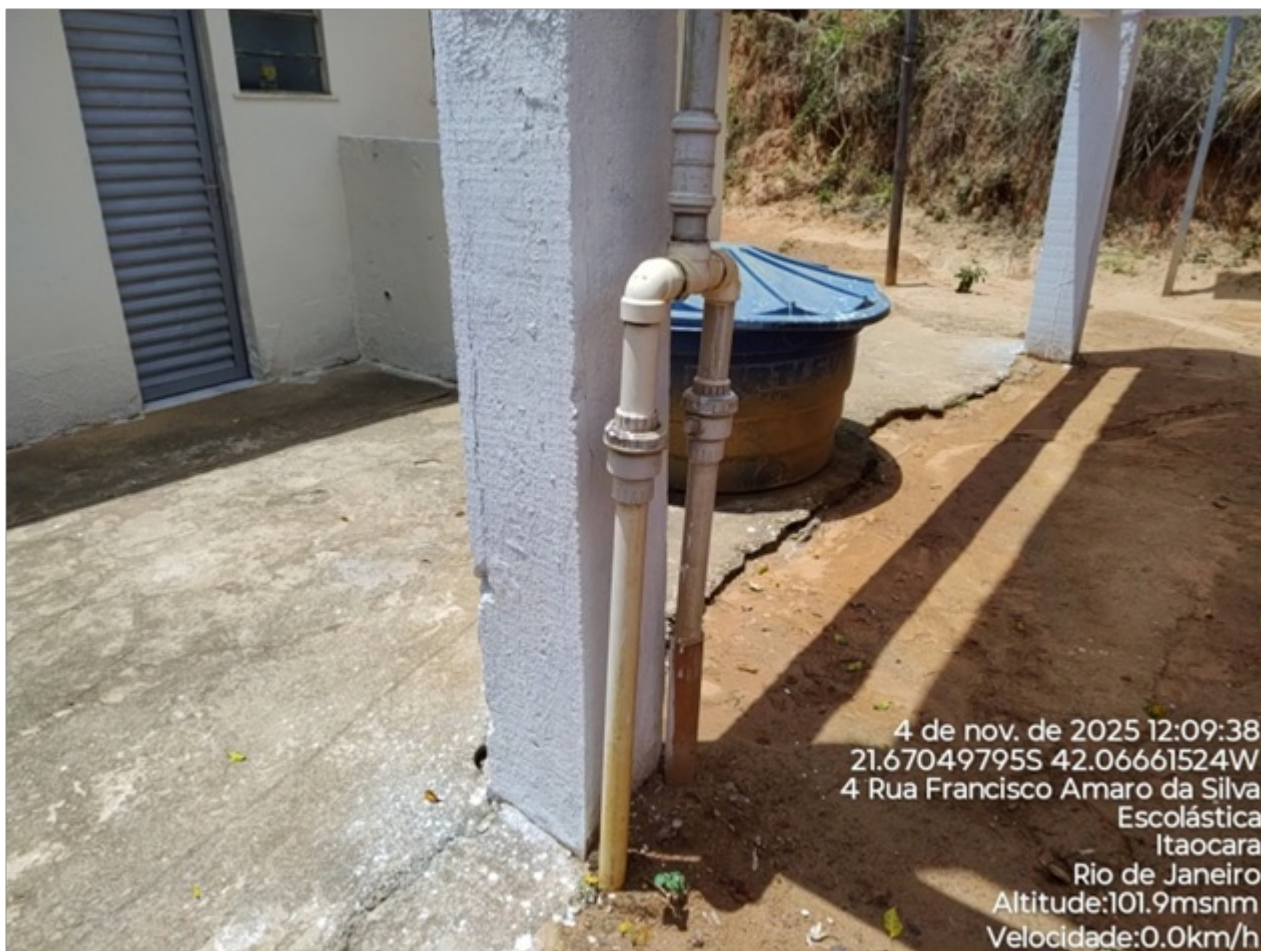
Foto 07: Tubulação de saída do resrvatório.
