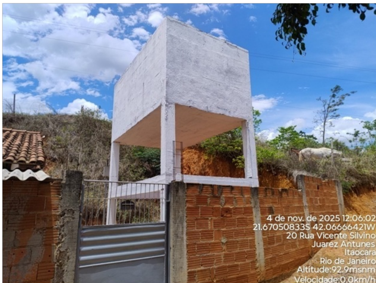
Foto 01: Reservatório isolado e com restrição de acesso.
