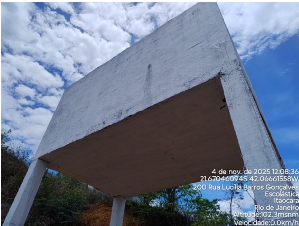
Foto 04: Vista da laje de fundo do reservatório.
