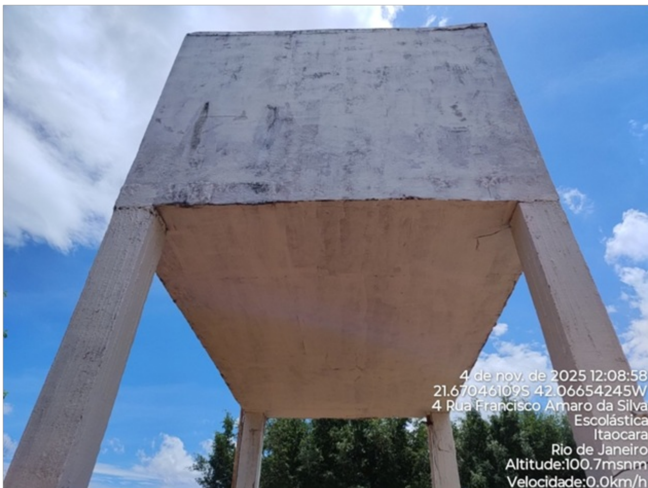
Foto 05: Vista da laje de fundo do reservatório.
