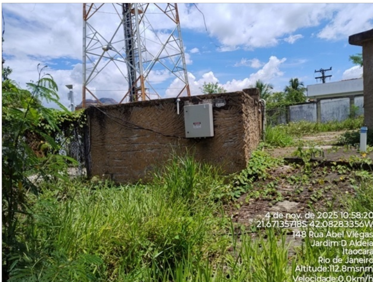
Foto 03: Vista do reservatório.
