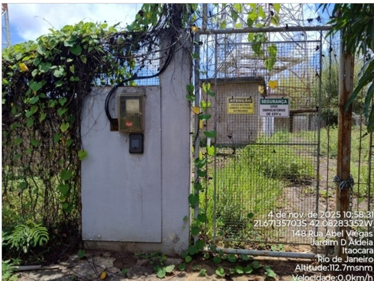
Foto 01: Reservatório isolado e com acesso restrito.
