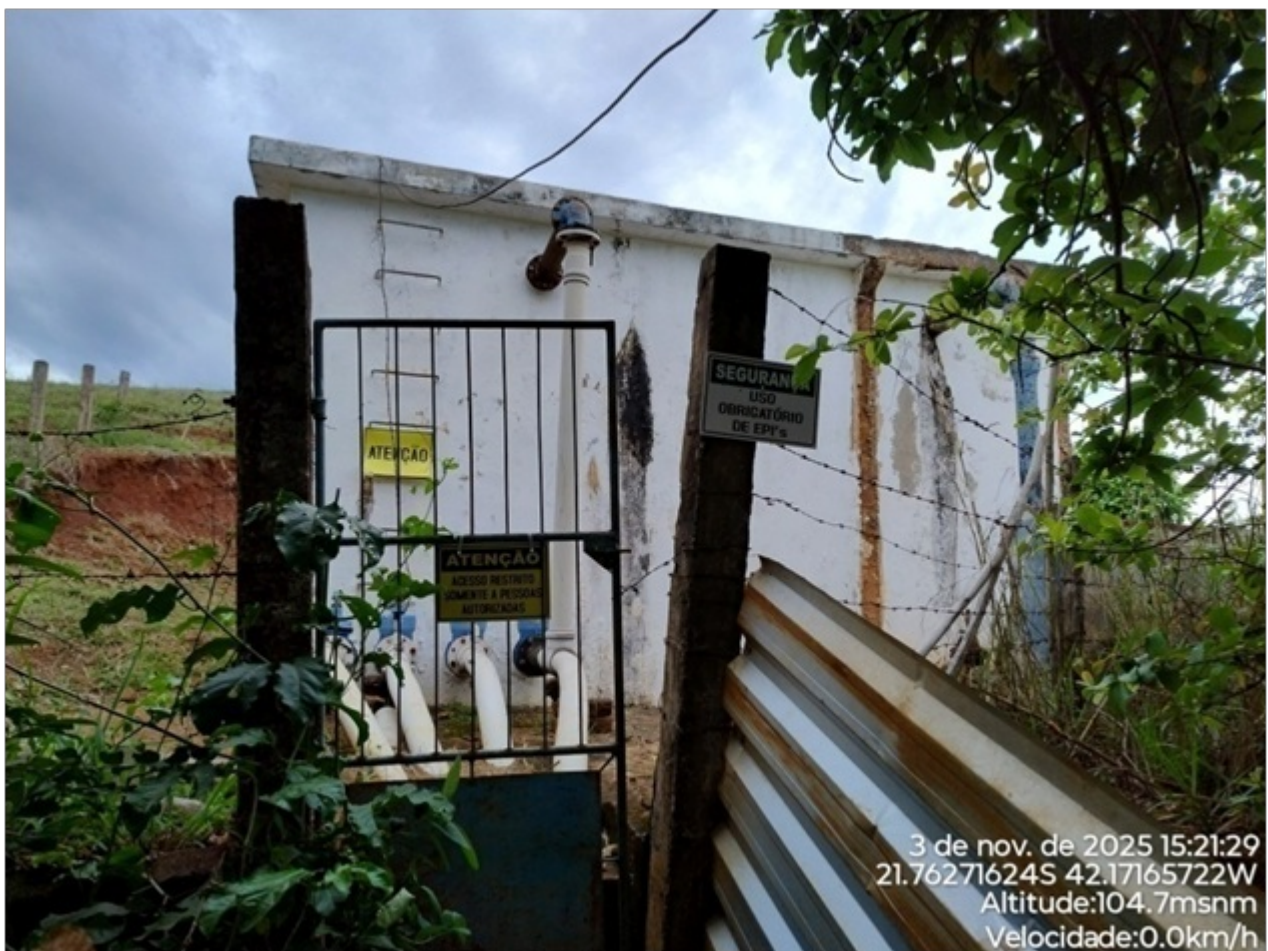
Foto 01: Acesso ao reservatório.
