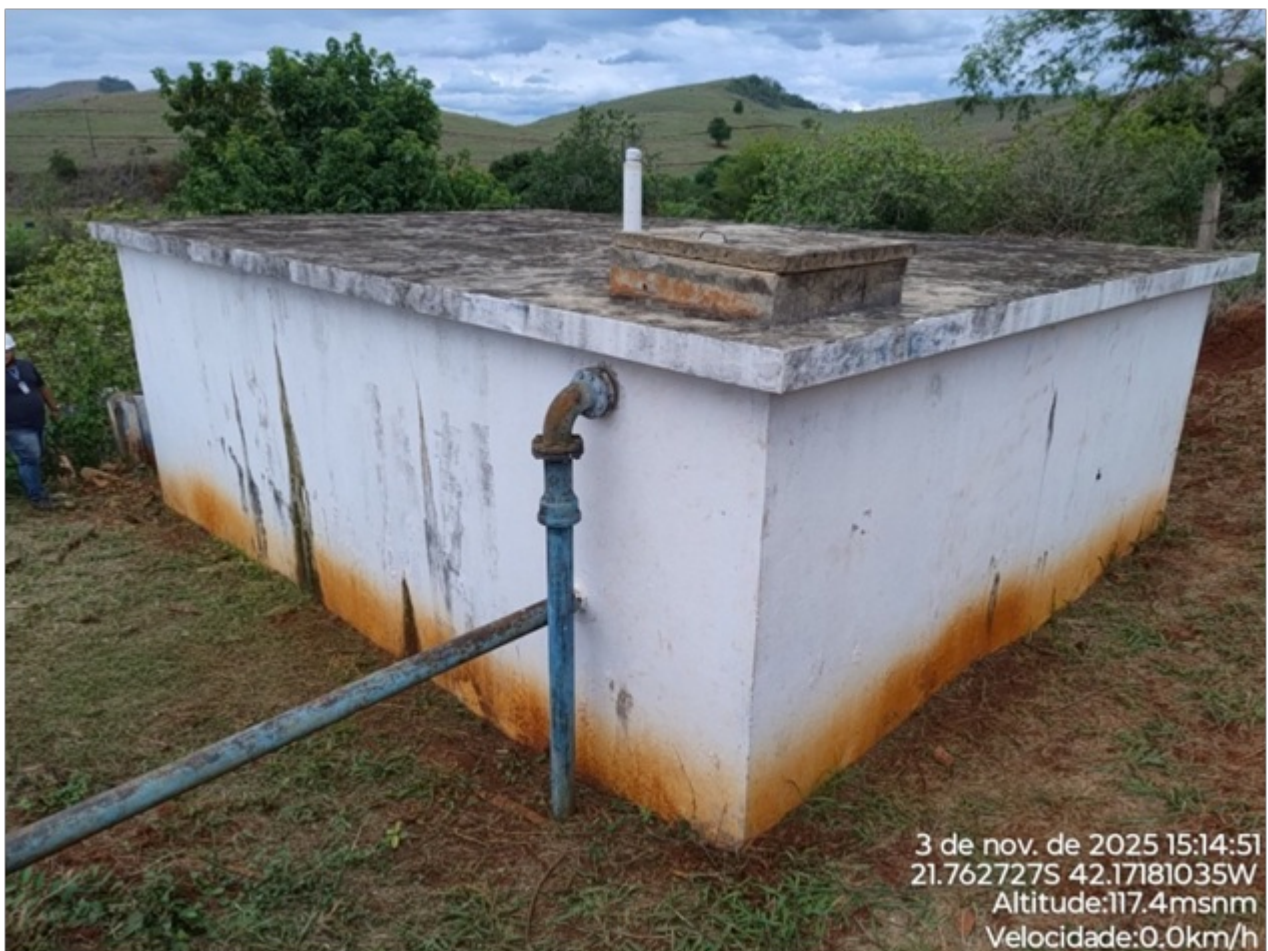
Foto 04: Vista parcial do reservatório.
