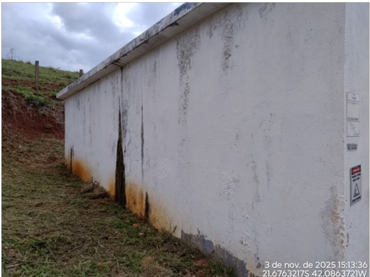
Foto 02: Vista da lateral do reservatório.
