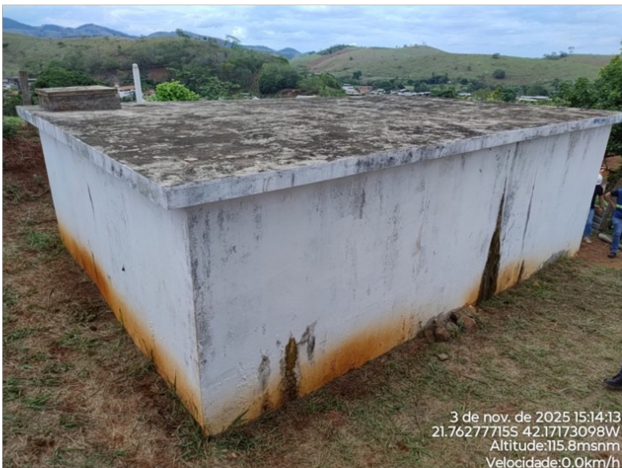
Foto 03: Vista parcial do reservatório.
