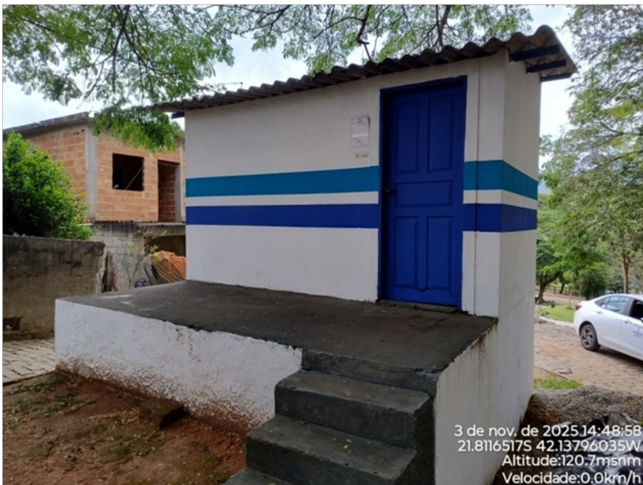
Foto 01: Reservatório com restrição de acesso.
