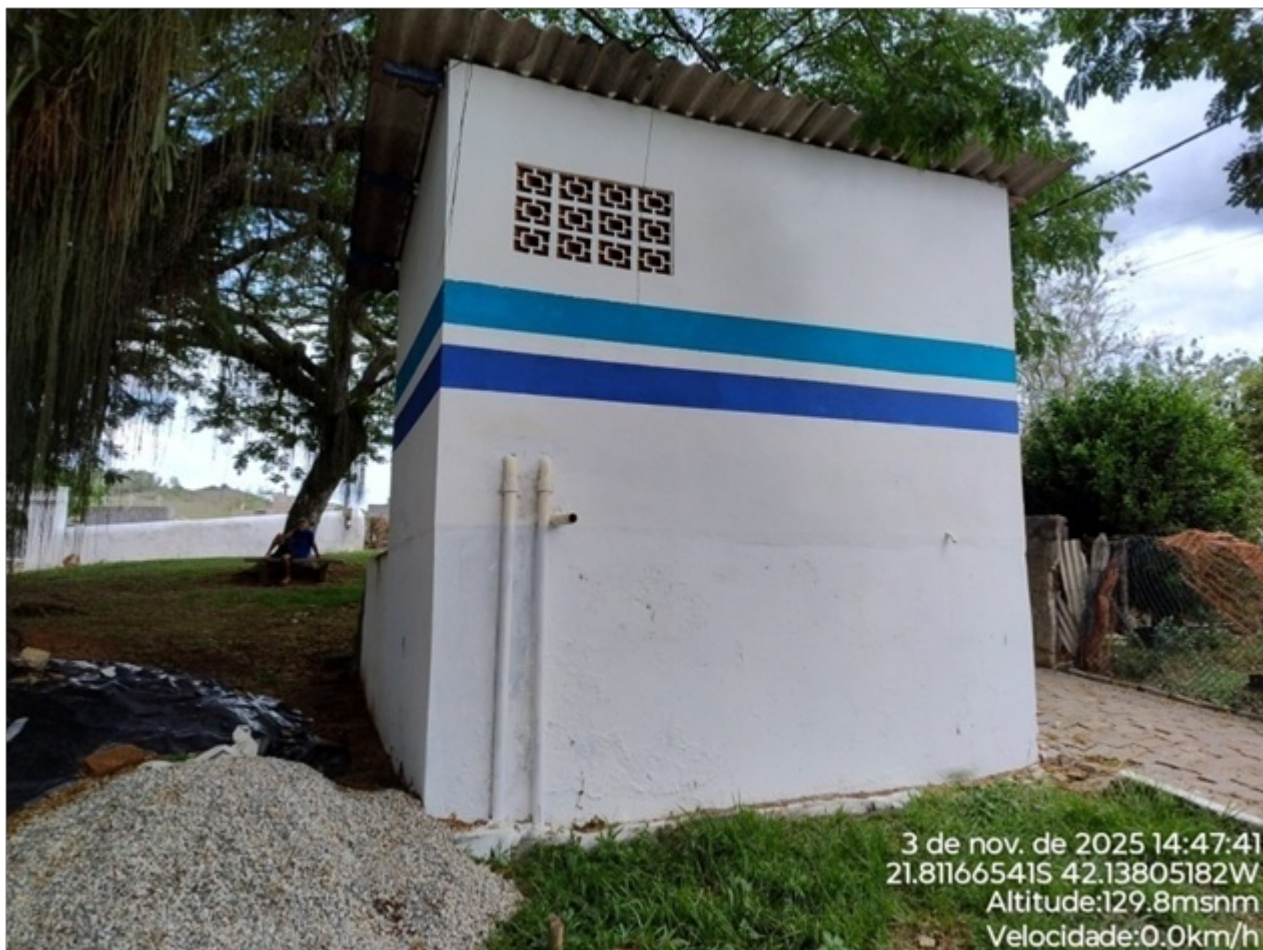
Foto 02: Vista do reservatório.
