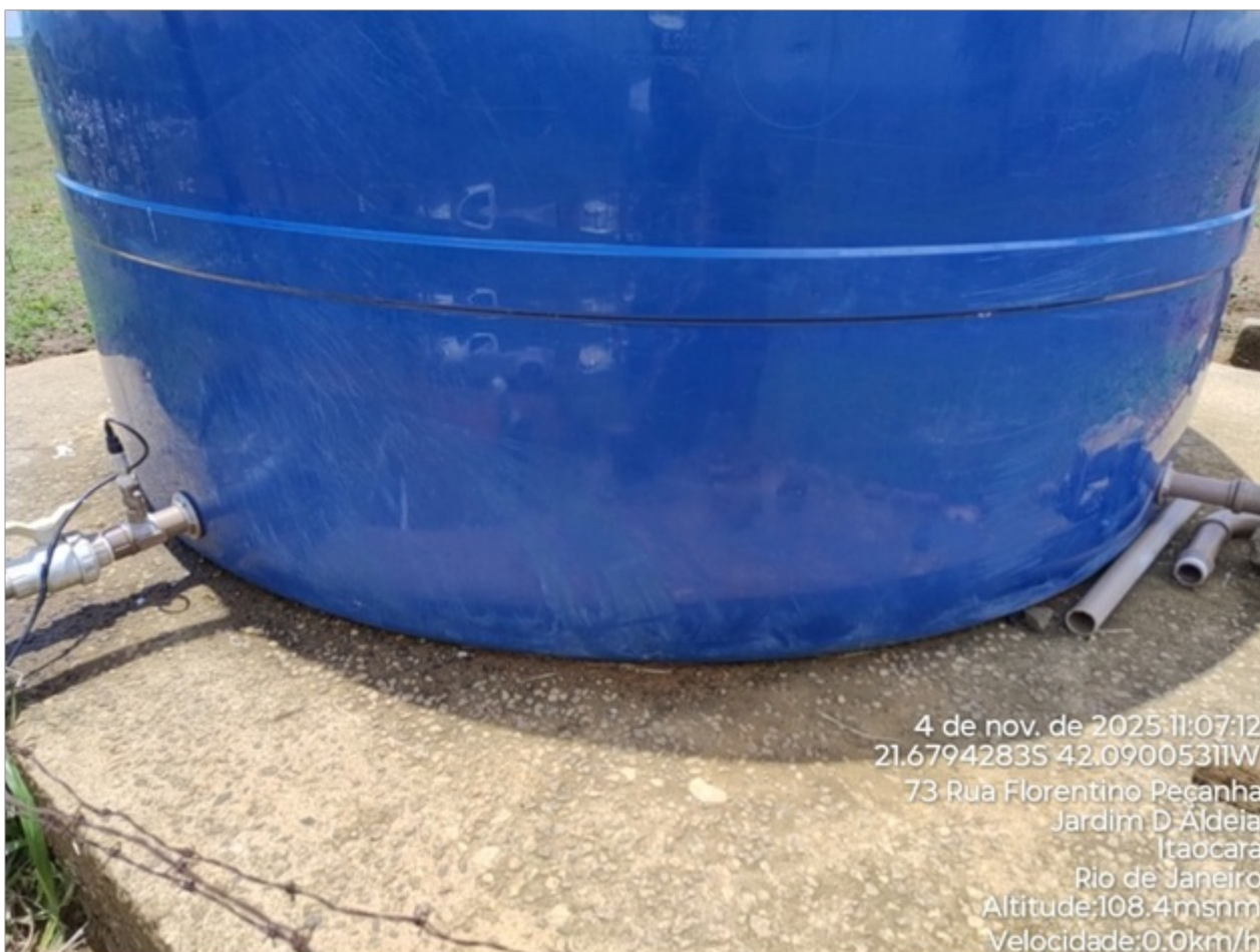
Foto 03: Vista do reservatório.
