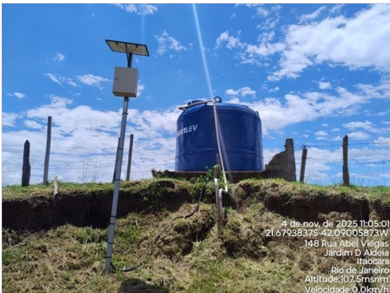
Foto 01: Vista do reservatório.
