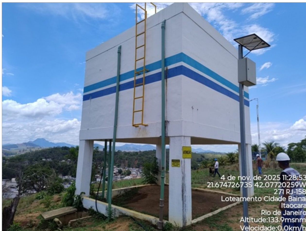
Foto 02: Vista da estrutura.
