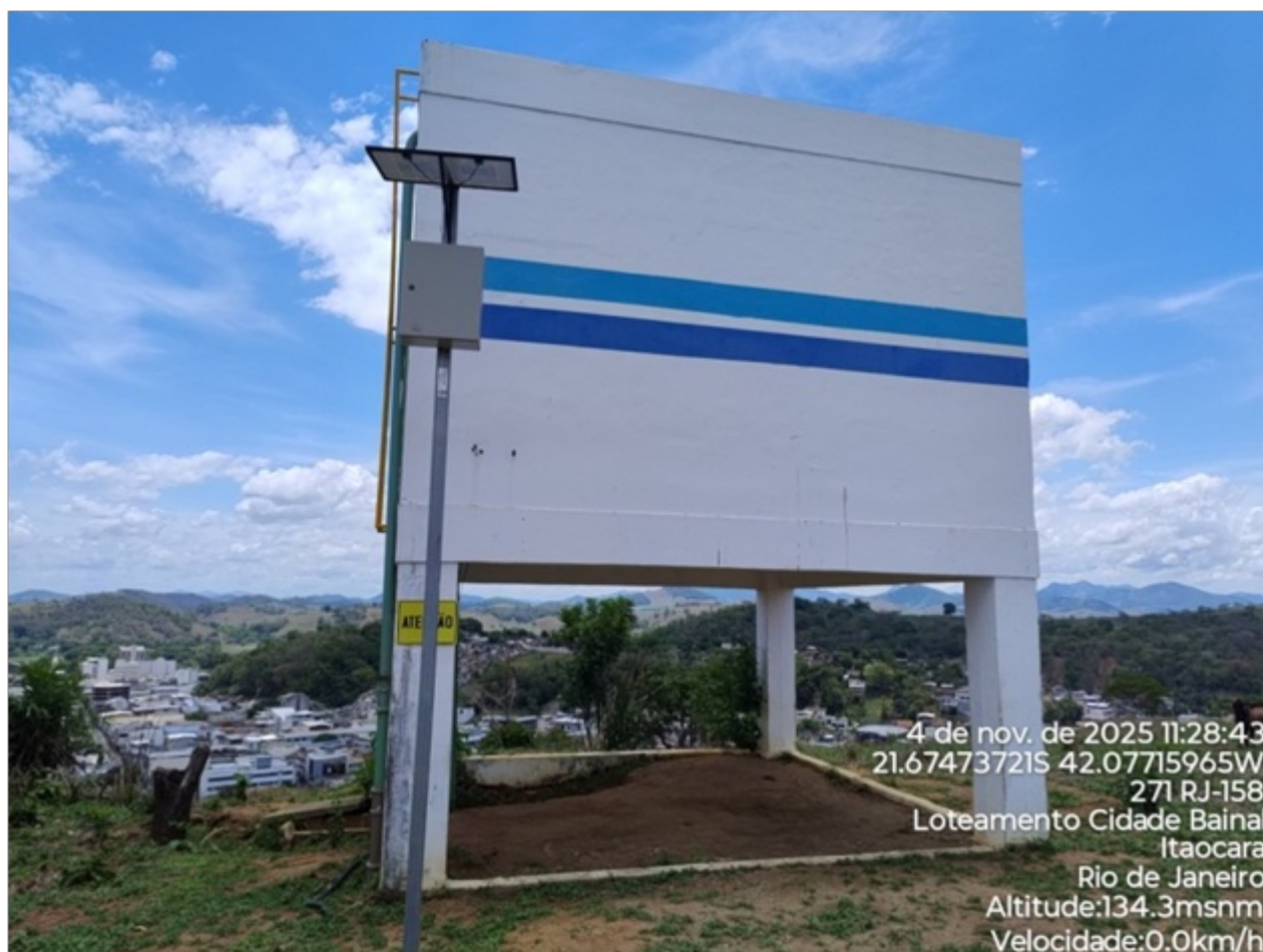
Foto 01: Vista da estrutura.
