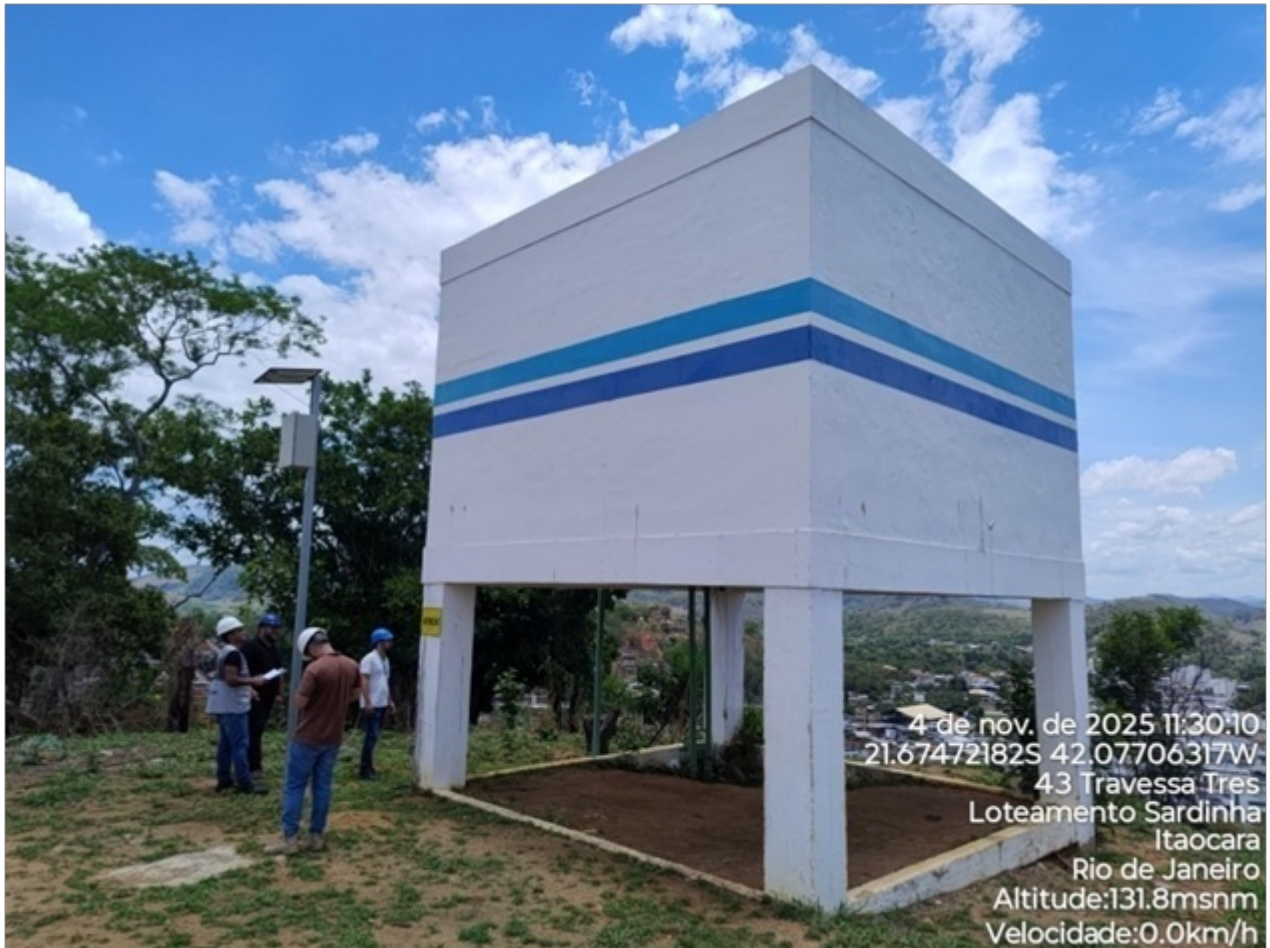
Foto 03: Vista da estrutura.
