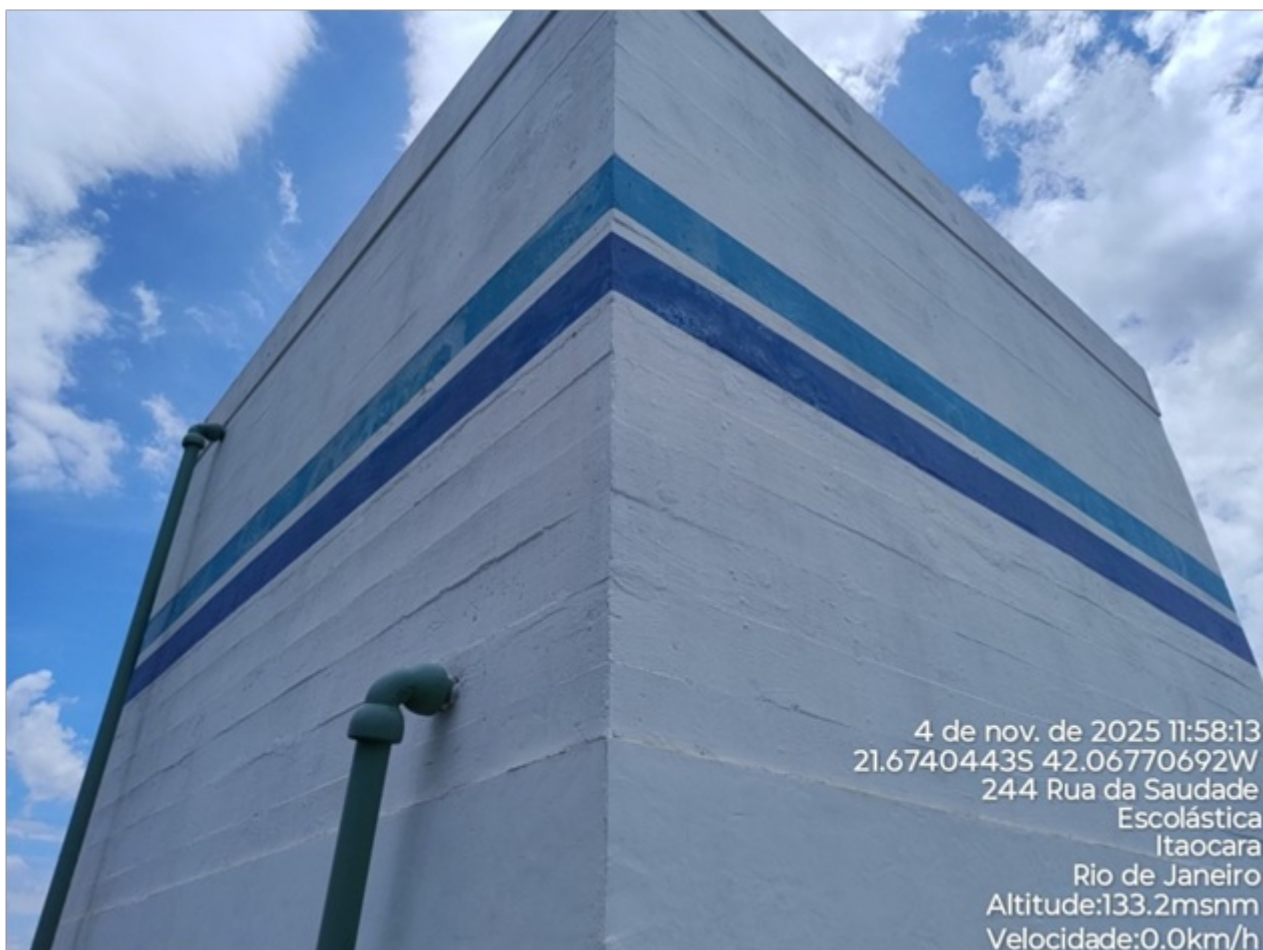
Foto 03: Vista lateral do reservatório.
