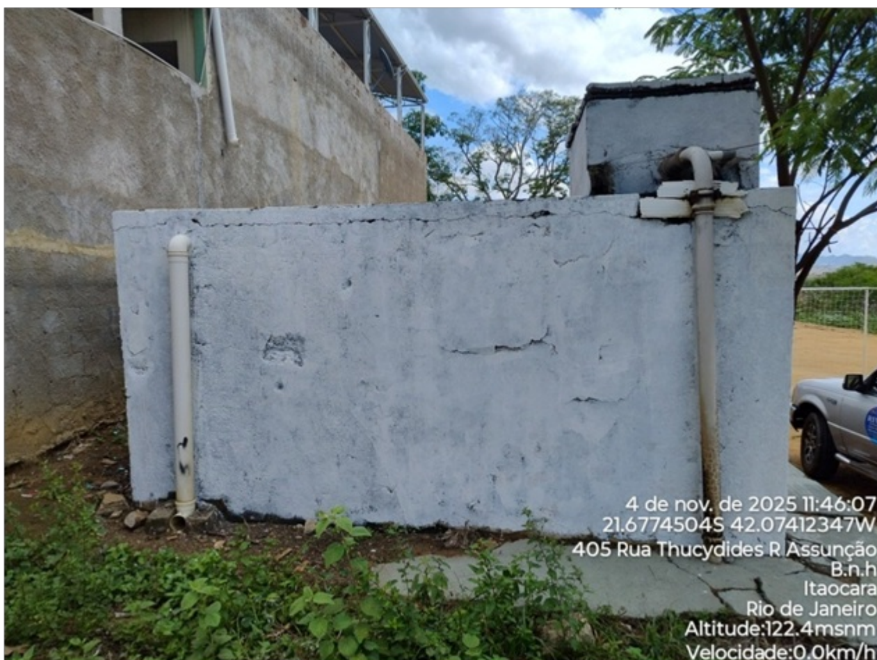
Foto 01: Vista frontal do reservatório.
