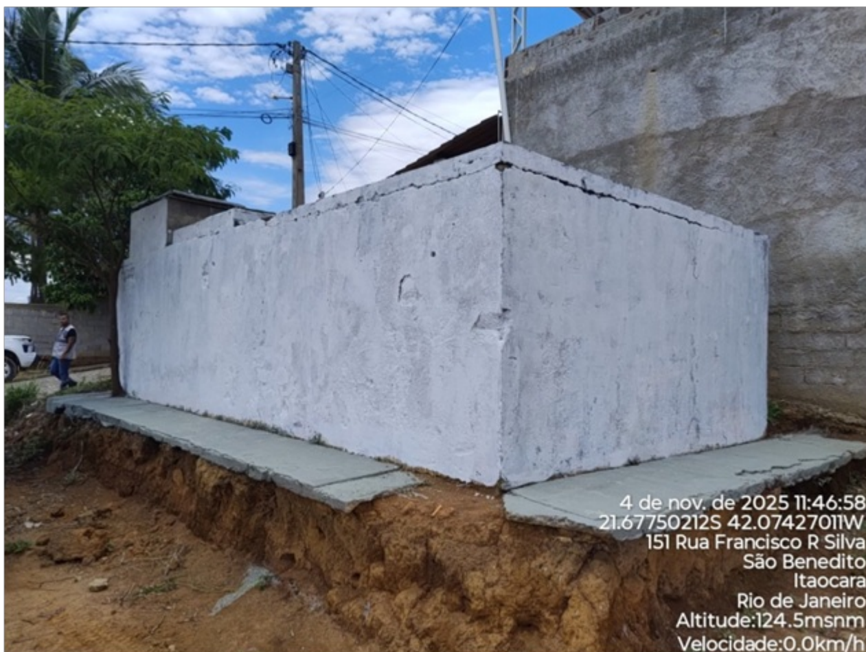
Foto 02: Vista lateral do reservatório.
