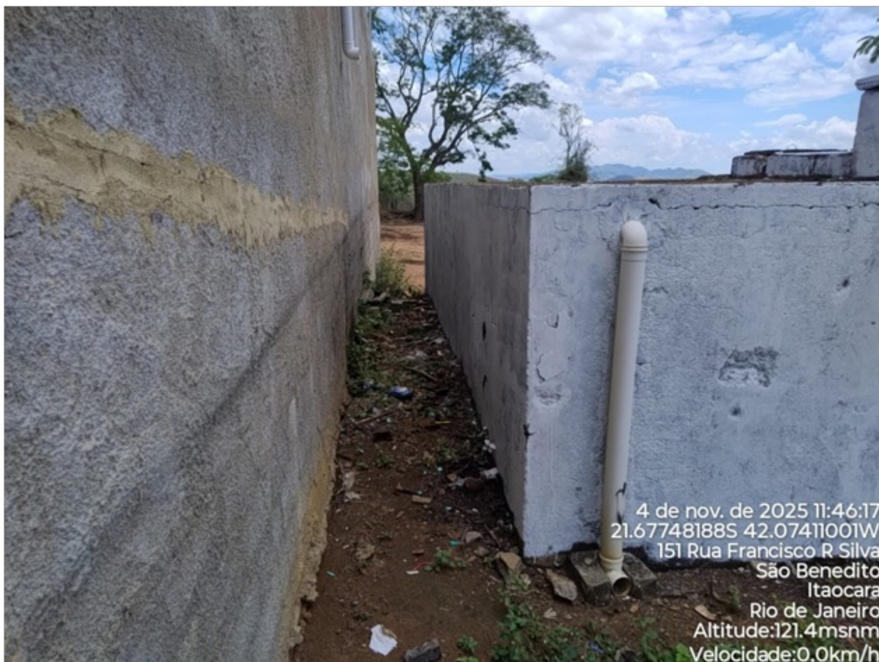
Foto 04: Vista da laje de cobertura do reservatório.
