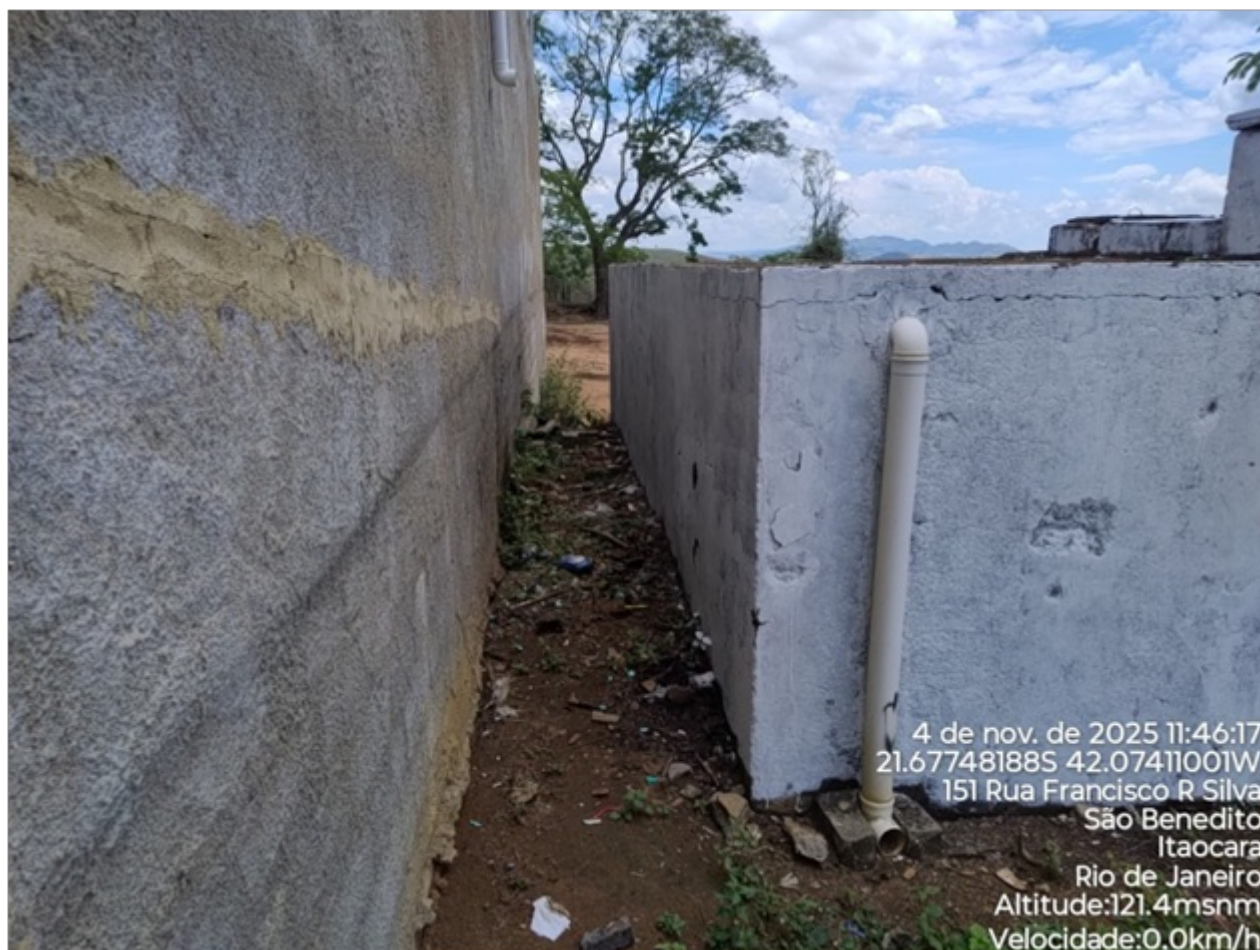
Foto 03: Vista lateral do reservatório.
