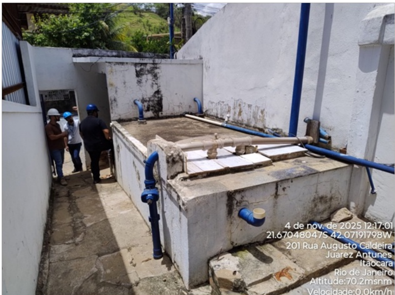
Foto 02: Reservatório da EEAT.
