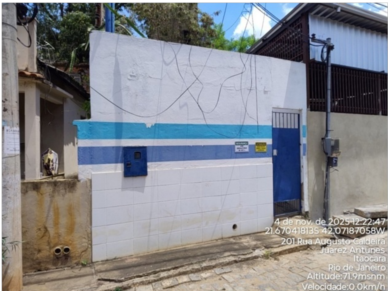
Foto 01: Vista frontal da EEAT com restrição de acesso.
