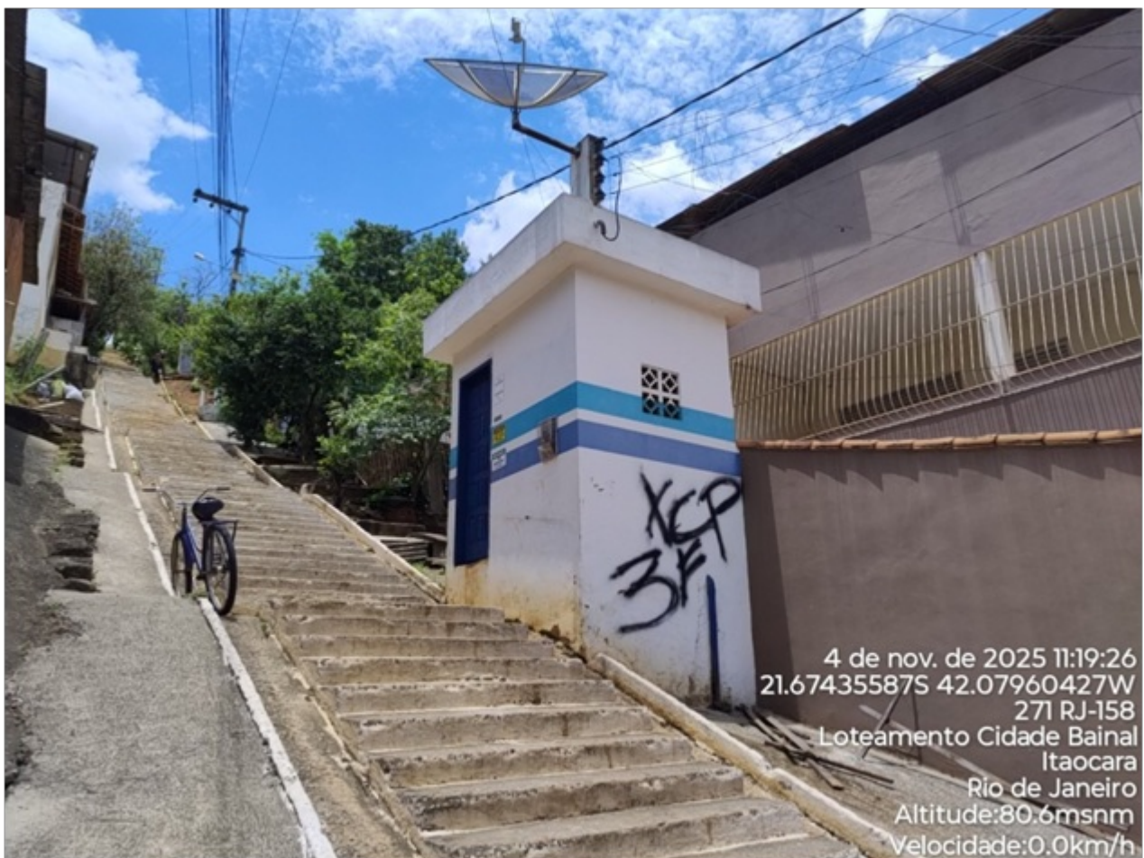
Foto 01: Abrigo da EEAT com restrição de acesso.
