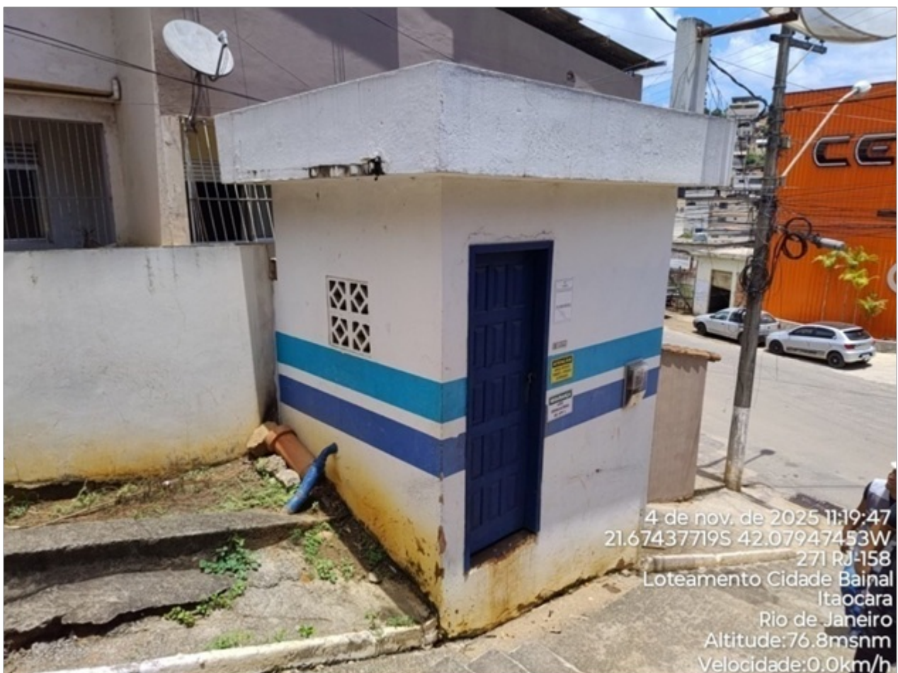
Foto 02: Abrigo da EEAT com restrição de acesso.
