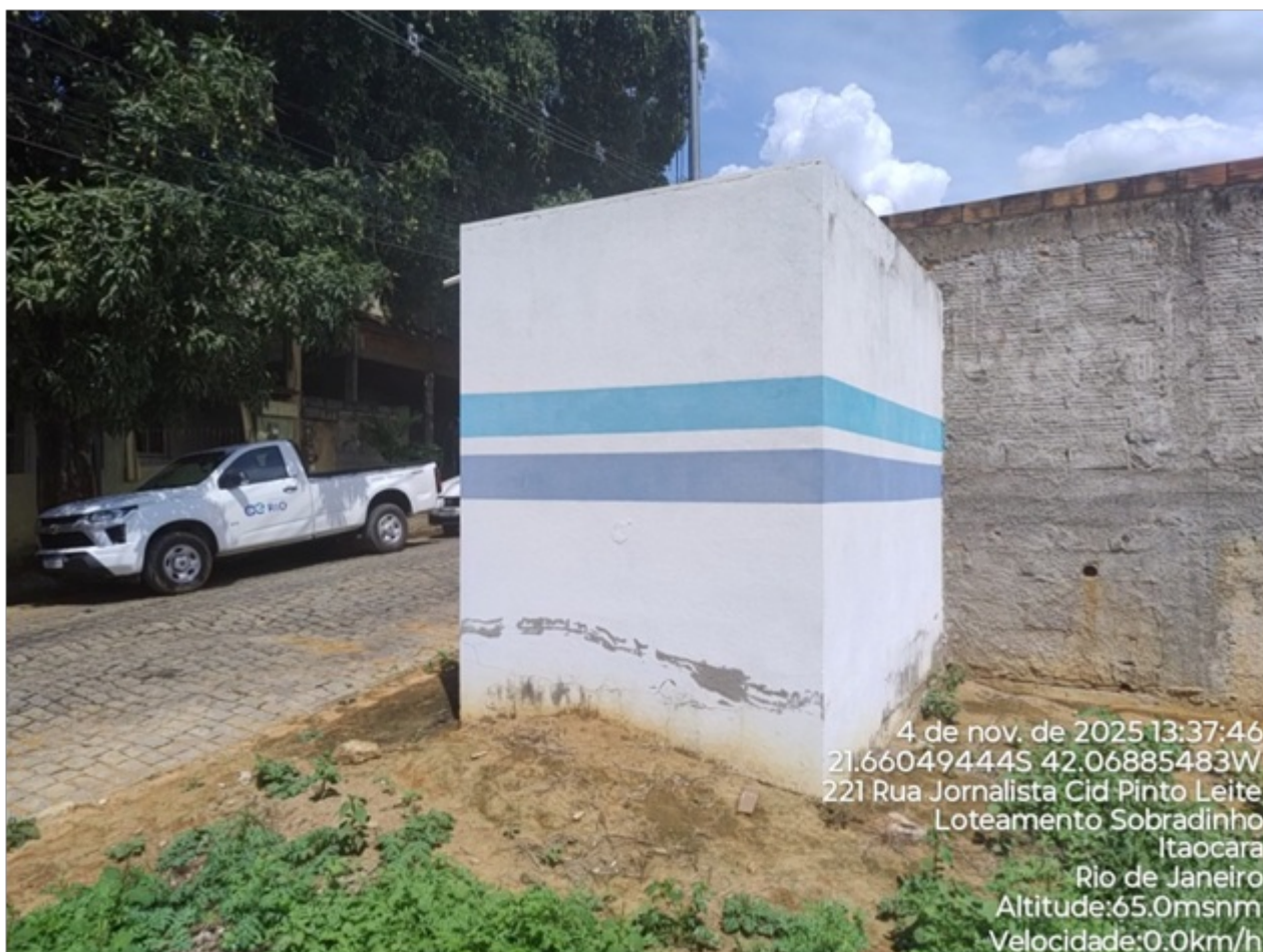
Foto 03: Vista lateral do abrigo da EEAT.
