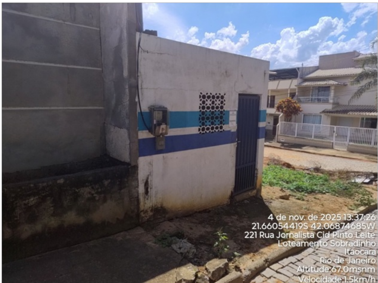
Foto 02: Abrigo da EEAT.
