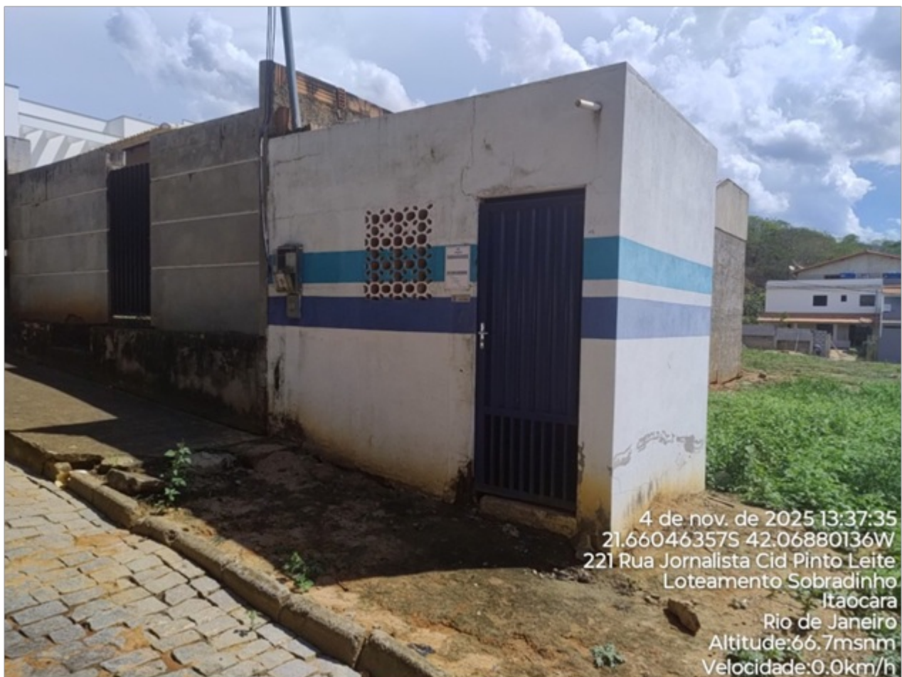
Foto 01: Abrigo da EEAT com restrição de acesso.
