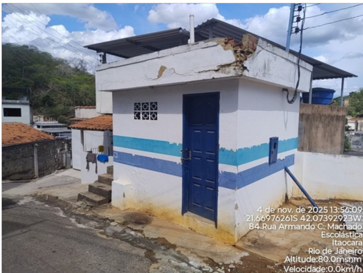
Foto 01: Abrigo da EEAT com restrição de acesso.
