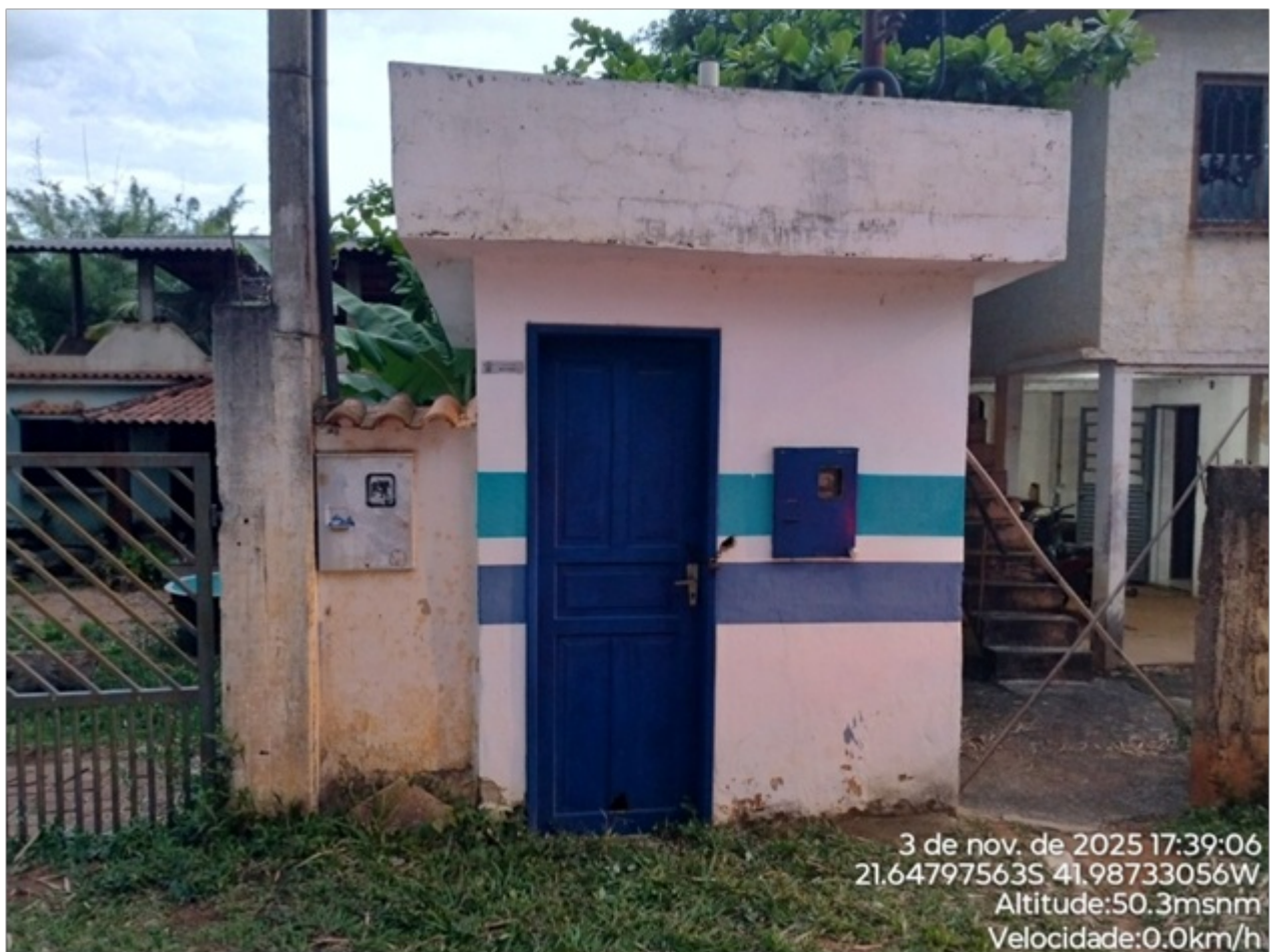
Foto 01: Abrigo da EEAT com restrição de acesso.
