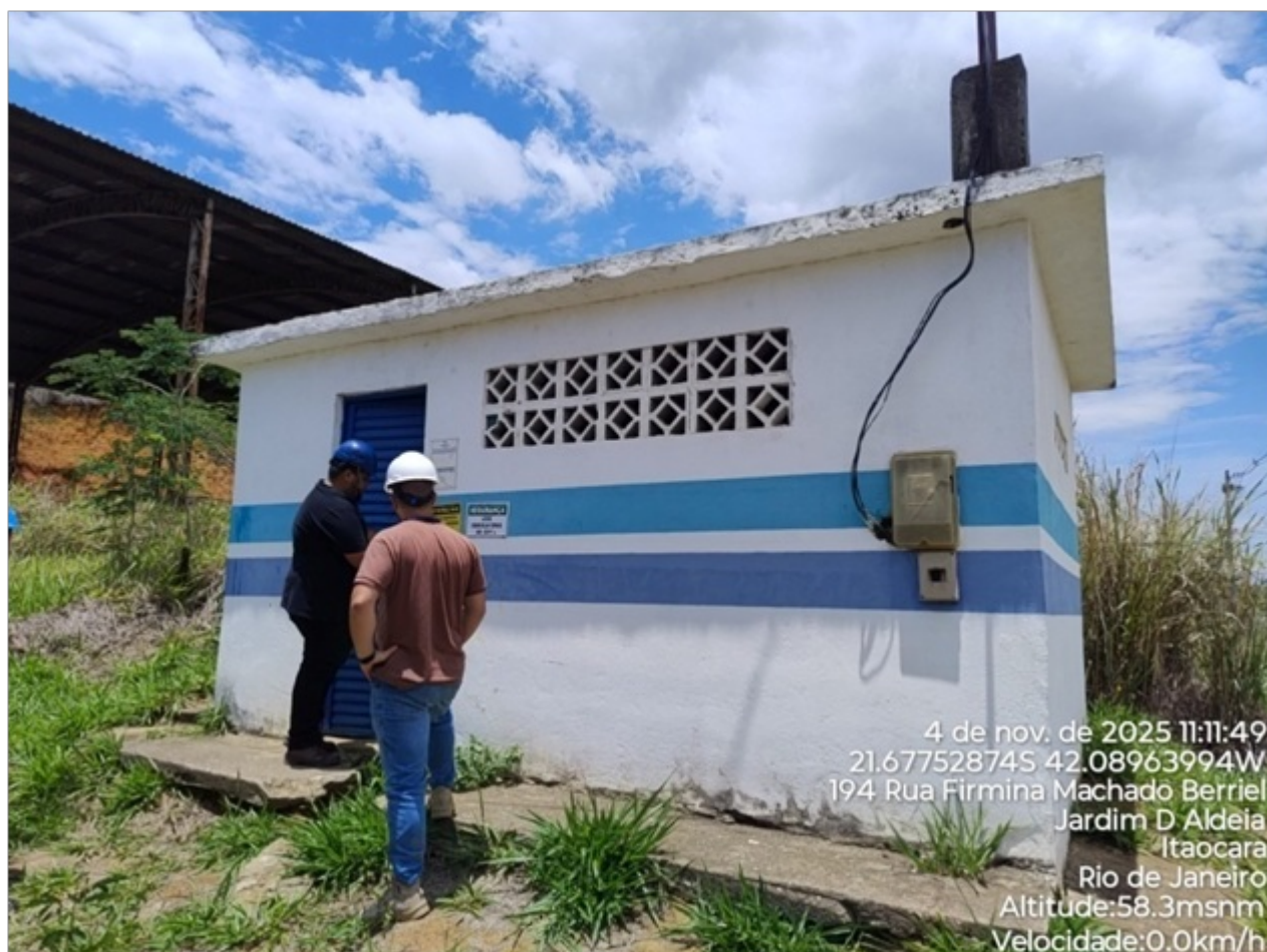
Foto 01: Abrigo da EEAT com restrição de acesso.
