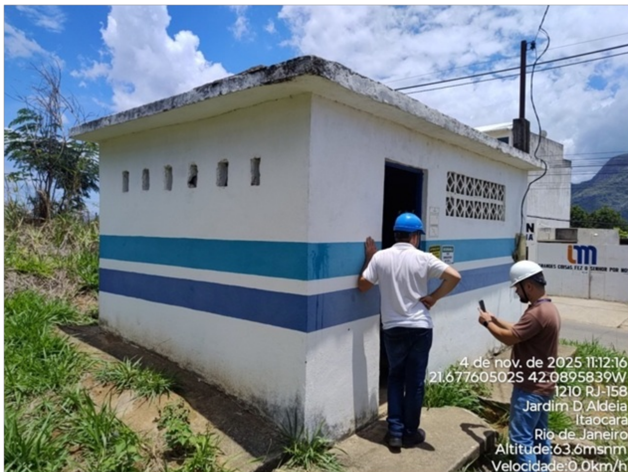
Foto 02: Abrigo da EEAT com restrição de acesso.
