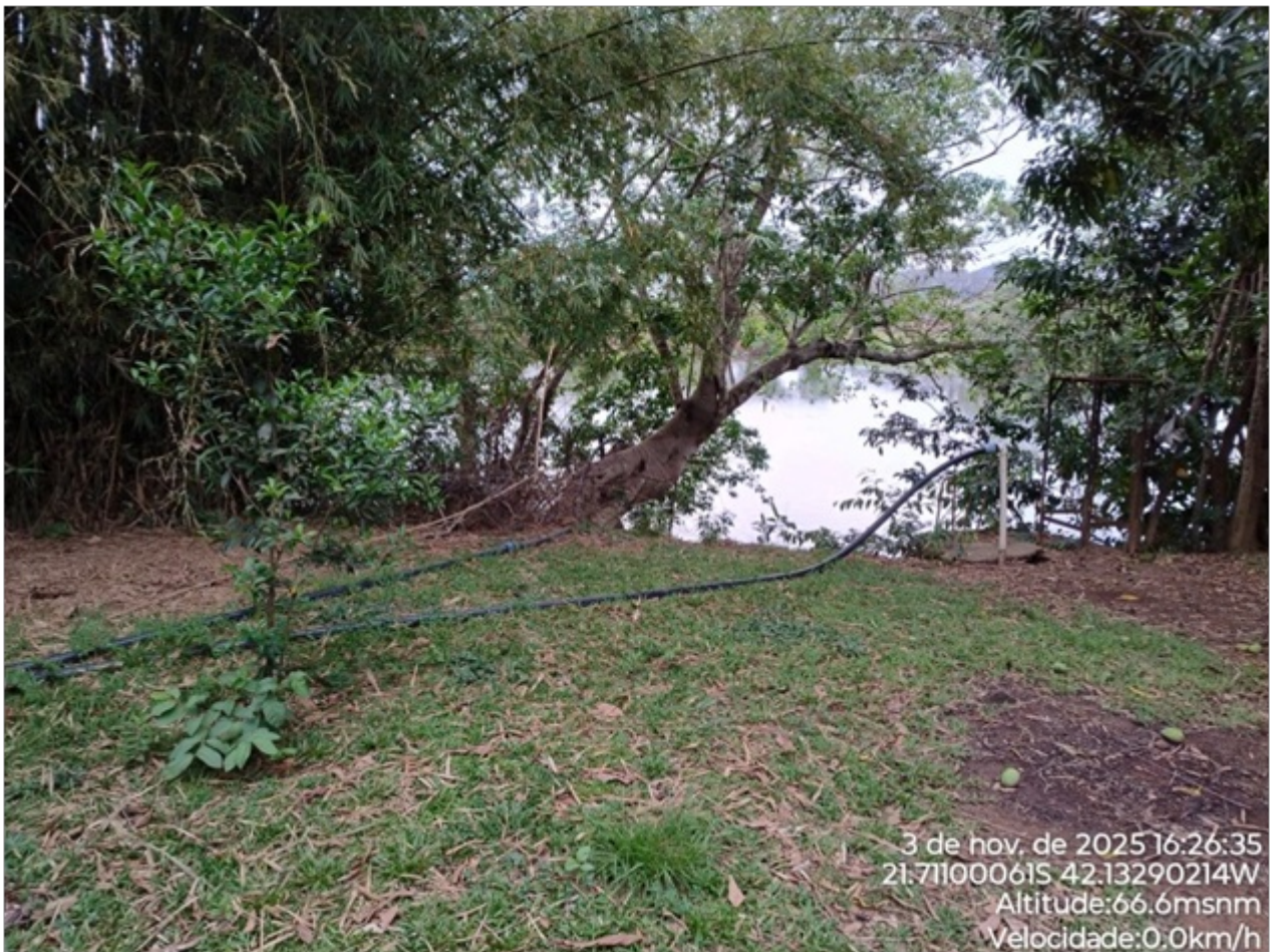
Foto 03: Tubulação de EEAB.
