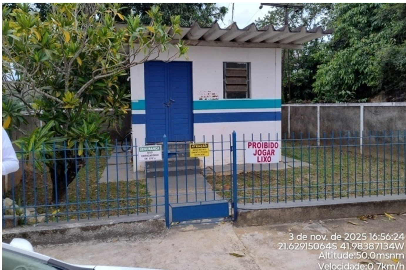
Foto 01: Abrigo da EEAB com isolamento e restrição de acesso.
