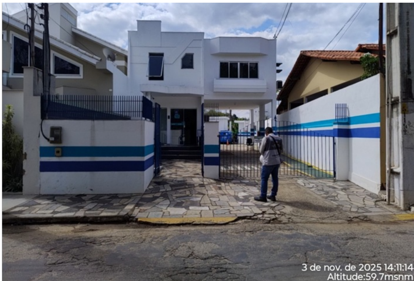
Foto 01: Acesso ao prédio de atendimento ao público, administração e captação.
