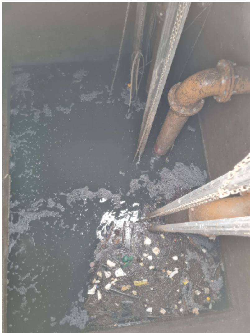
Figura 4. Poço de sucção com presença de sólidos grosseiros.
