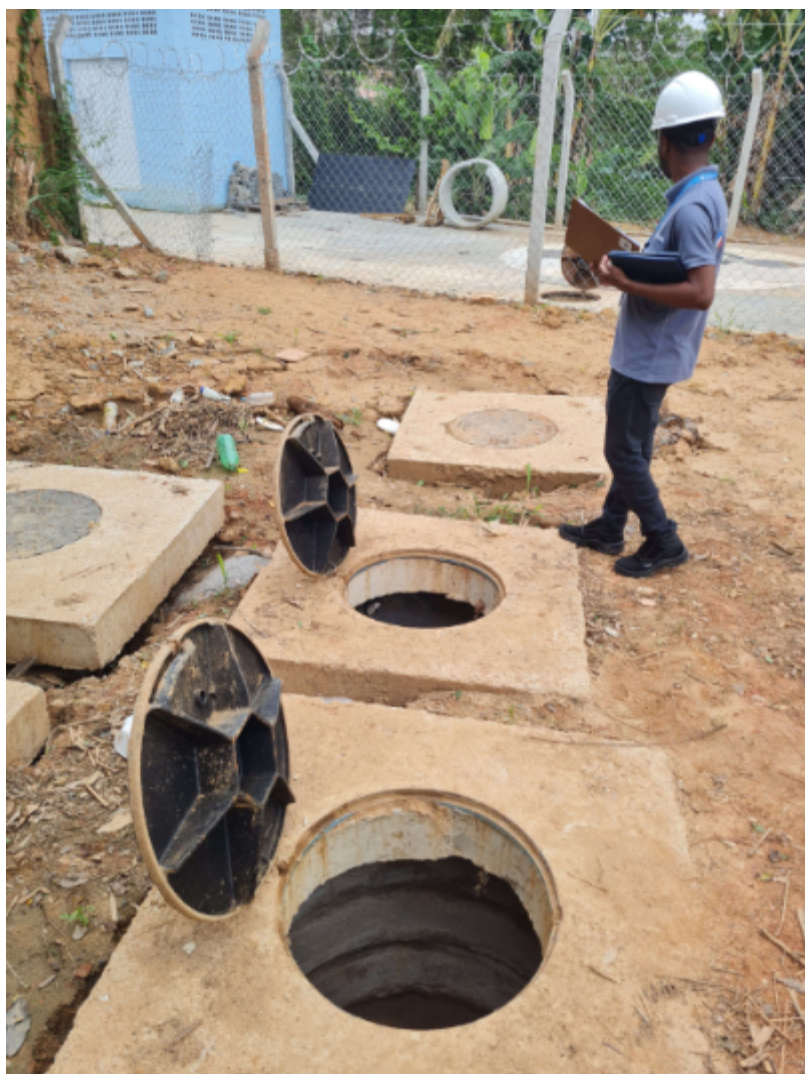
Figura 3. Situação do acesso aos PVs de entrada da elevatória e CTS.
