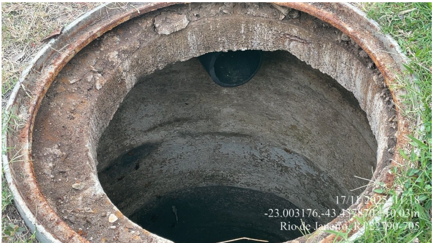
Foto 6 – Poço de chegada do esgoto com extravasor
