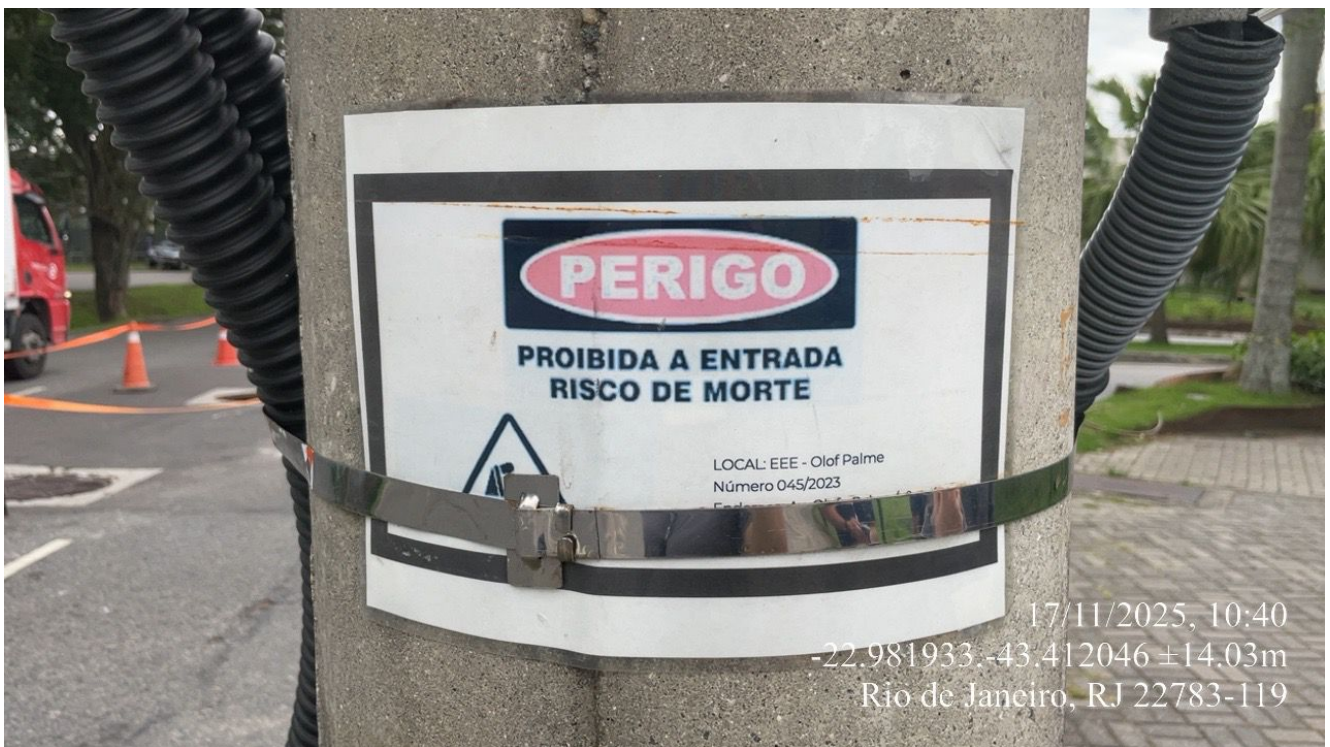
Foto 3 – Sinalização de perigo e identificação da EEEB no poste
