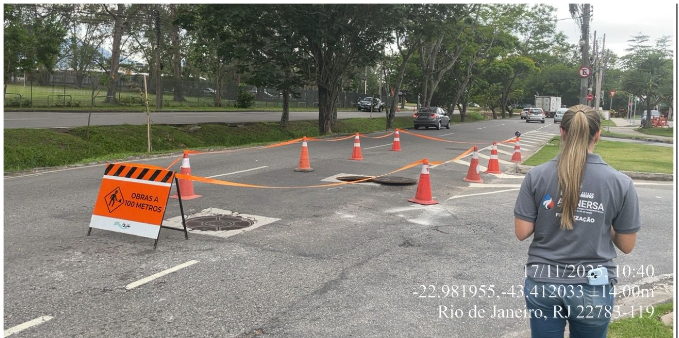
Foto 4 – Poço de chegada do esgoto devidamente coberto
