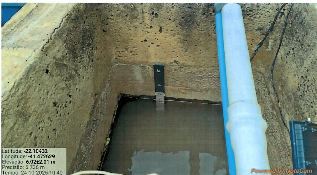
Foto 6: Nova régua de medição instalada na entrada da VETA para medição de vazão.
