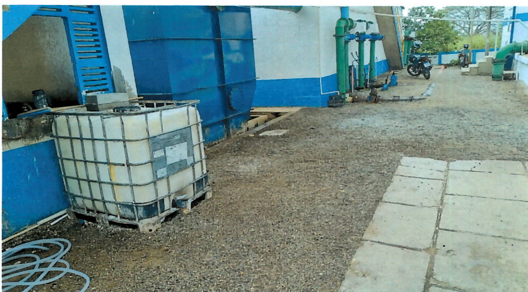
Foto 22: Local onde estavam armazenados os tanques de sulfato de alumínio (o container branco que consta na fotografia está vazio aguardando remoção).
