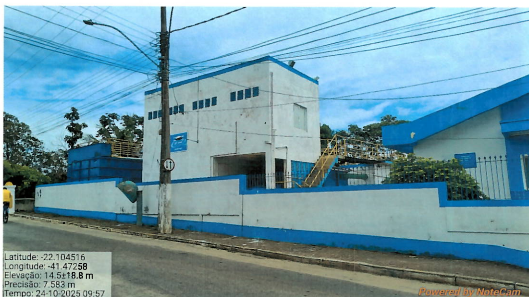
Foto 2: Fachada da ETA (note-se adequação realizada no muro e realização de pintura).
