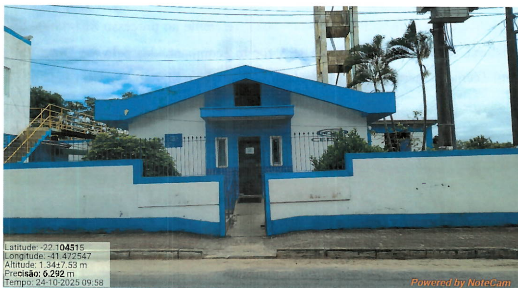
Foto 1: Fachada da ETA (note-se adequação realizada no muro e realização de pintura).
