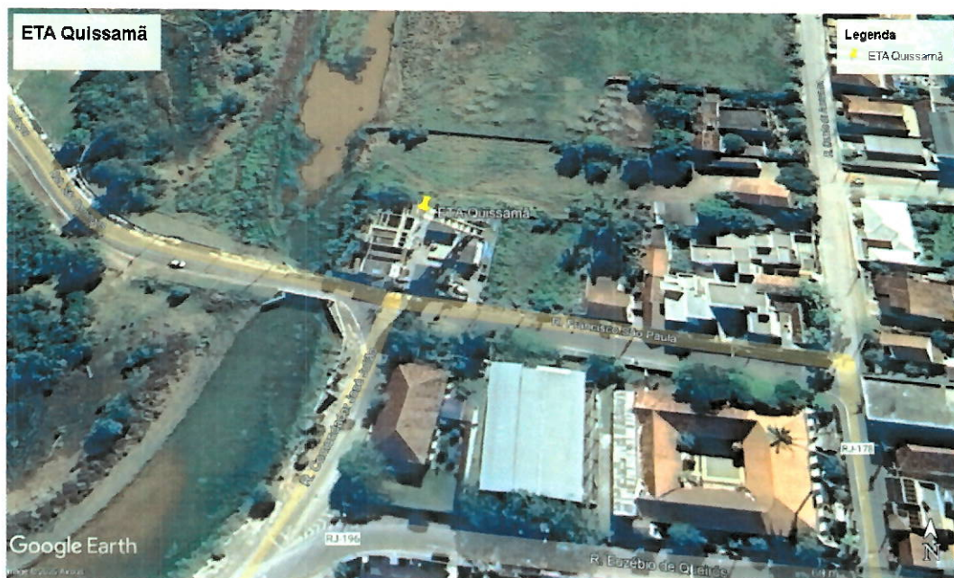
Imagem 1: Localização da ETA Quissamã (22° 6'16.00"S 41°28'21.06"O).
