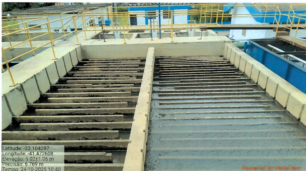
Foto 8: Floculadores da VETA (hidráulico)
