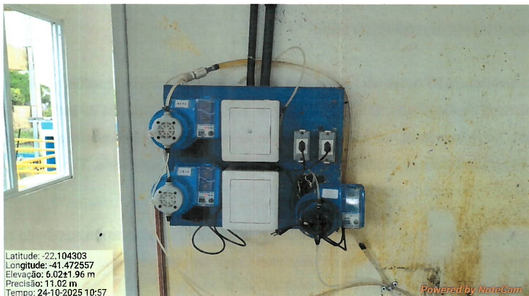
Foto 19: Dosadores de sulfato de alumínio adquiridos.
