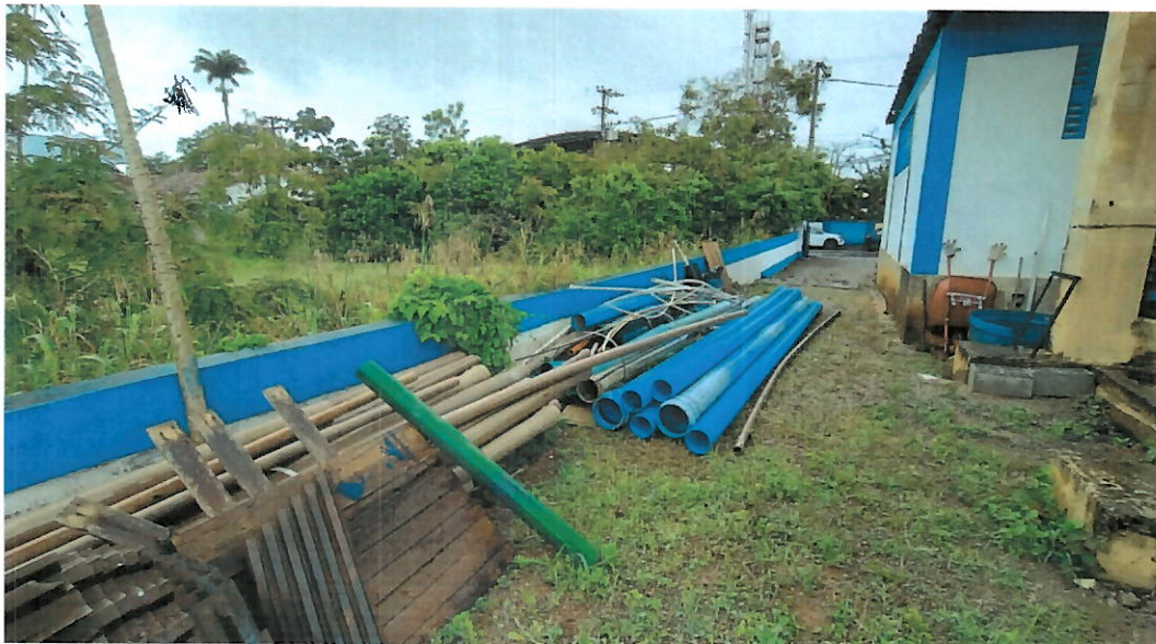
Foto 4: Vista do muro lateral (nota-se a baixa altura).
