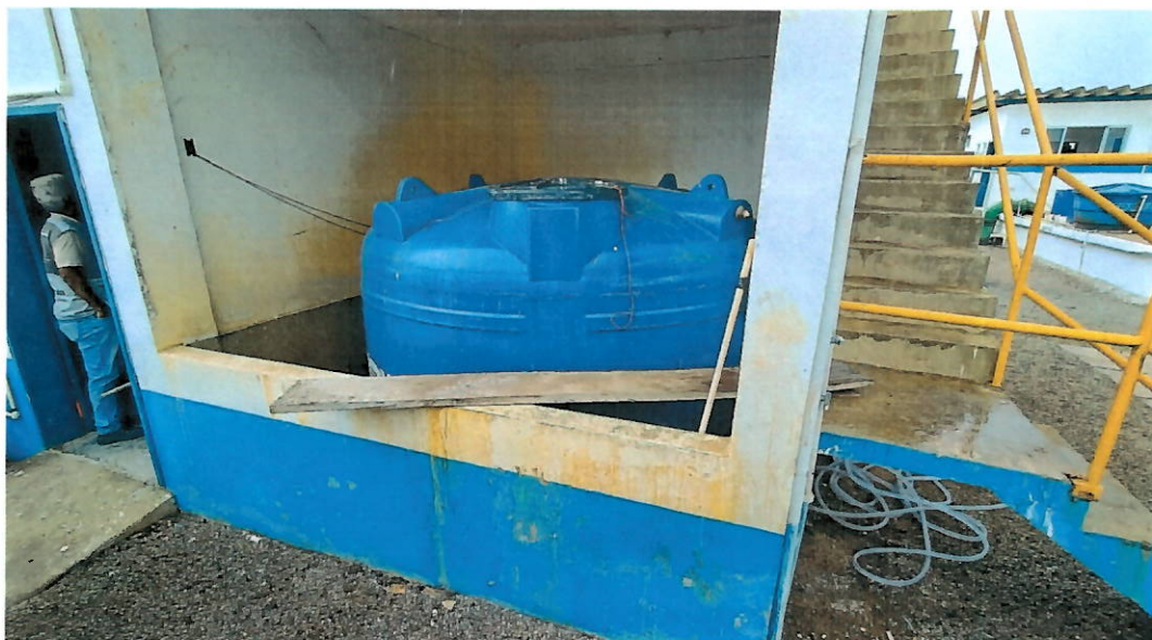
Foto 21: Armazenamento de sulfato de alumínio.
