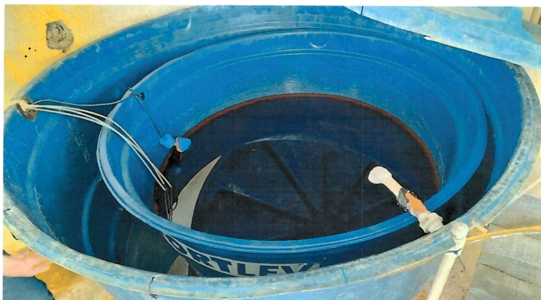
Foto 18: Armazenamento de sulfato de alumínio.
