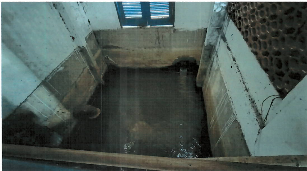
Foto 3: Poço de recalque da elevatória.
