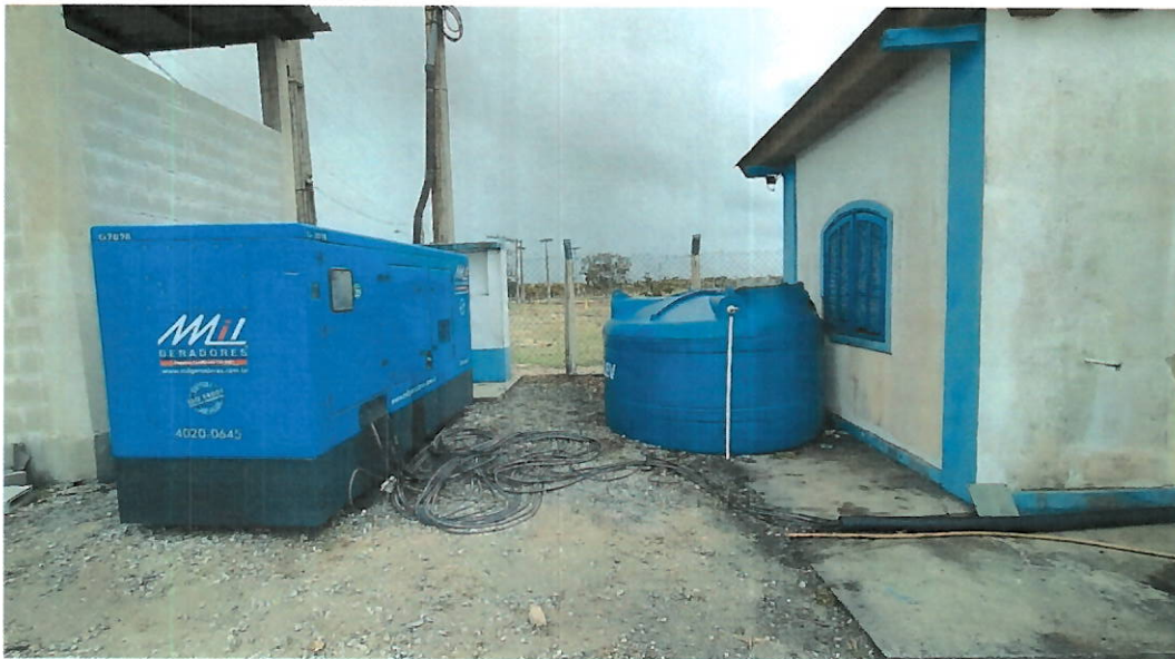
Foto 7: Gerador de energia, à esquerda, e tanque de diluição de carvão ativado, à direita.
