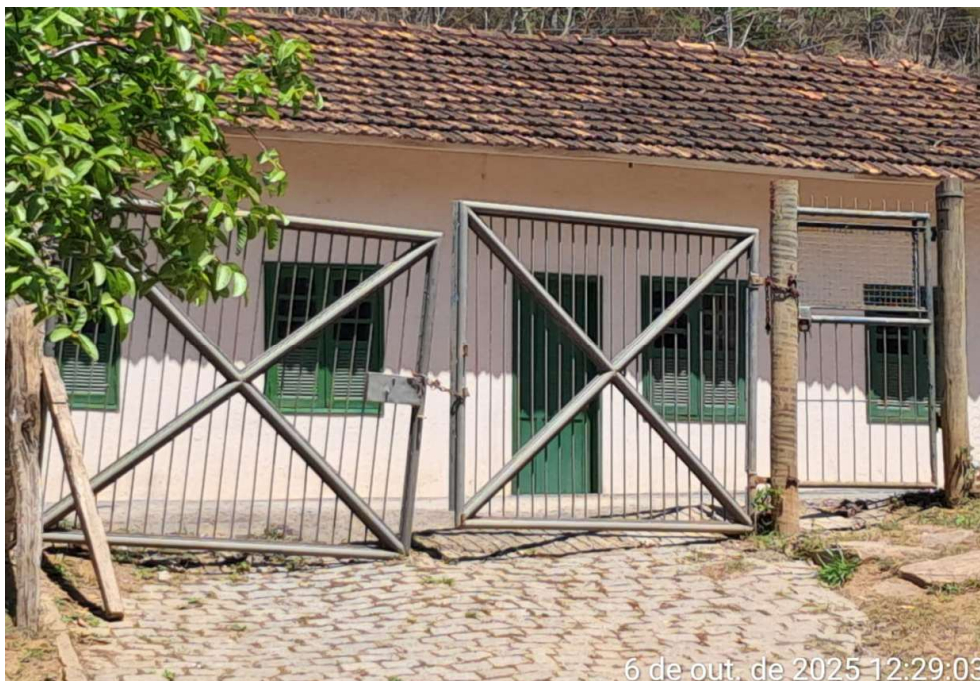
Foto 1 – Portão de acesso à captação sem identificação
