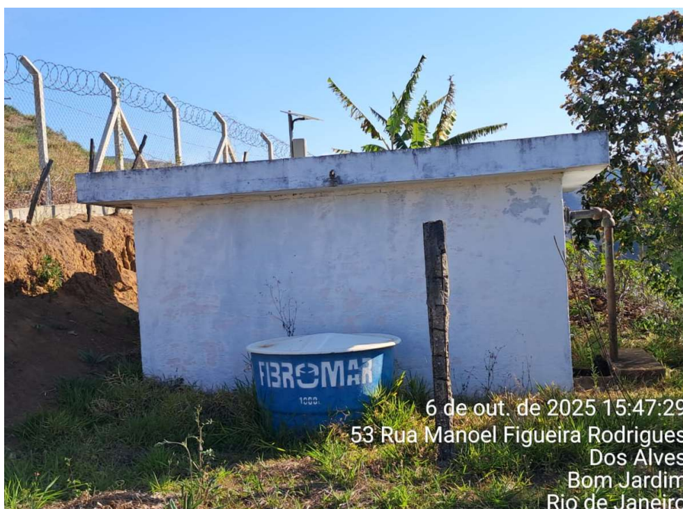
Foto 27 – Reservatório dos Alves
