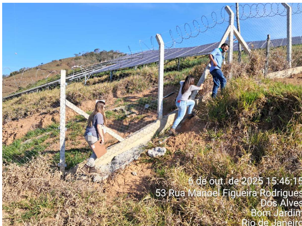
Foto 26 – Acesso precário ao local
