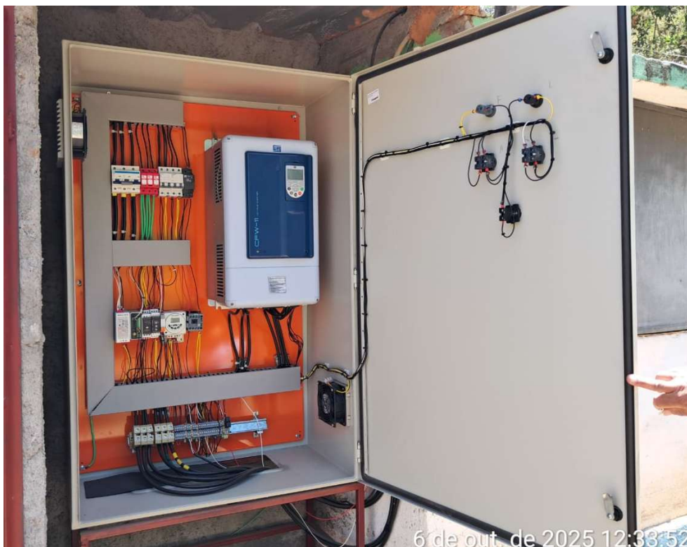
Foto 6 – INVERSOR DE FREQUÊNCIA
