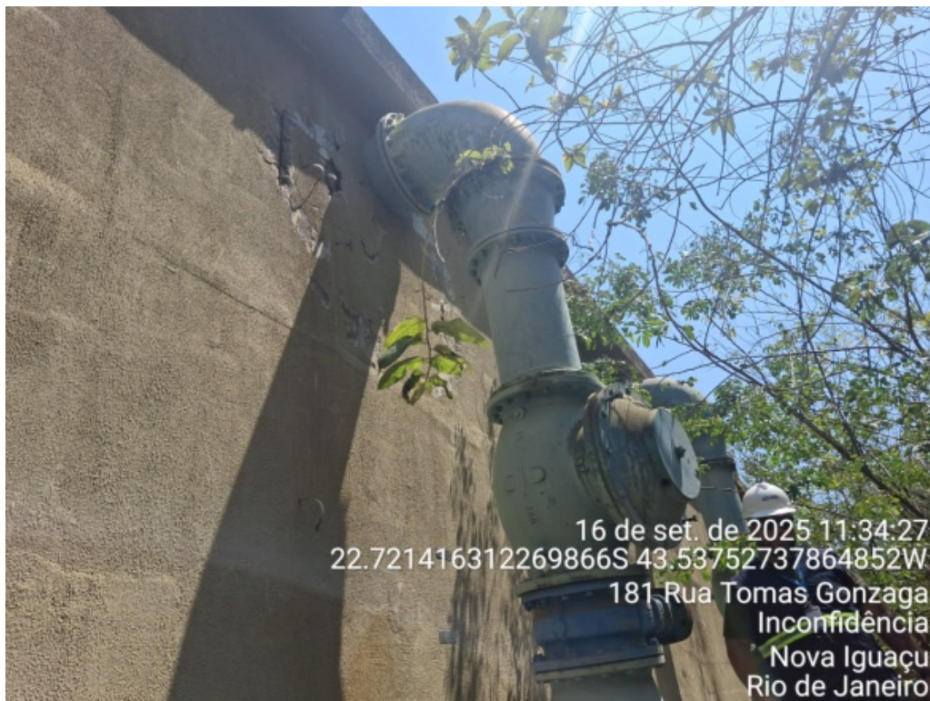
Foto 5: Área reservatório – Tubulação de chegada
