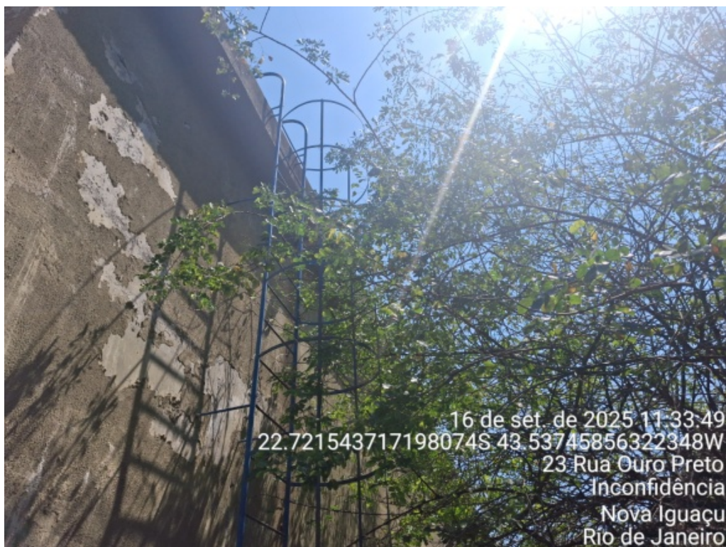
Foto 7: Escada de acesso a laje
