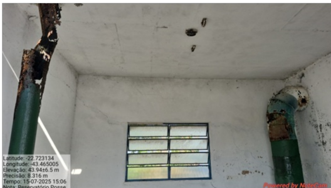
Foto 6: Tubulações oxidadas
