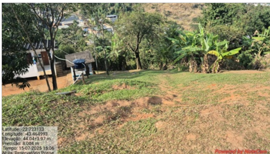
Foto 7: Área reservatório – Caminho tubulação de chegada
