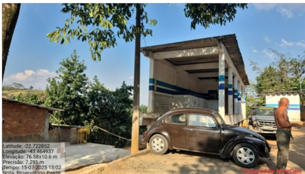
Foto 2: Área operacional do reasevatório
