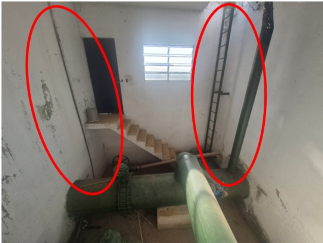
Foto 9: Barrilete ( Destaque nível e escada)
