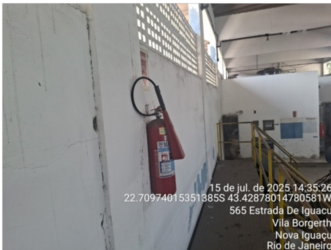
Foto 8 – Extintor instalado
