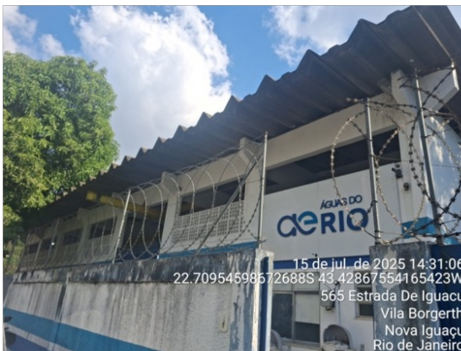
Foto 1 – Abrigo booster (ou elevatória)
