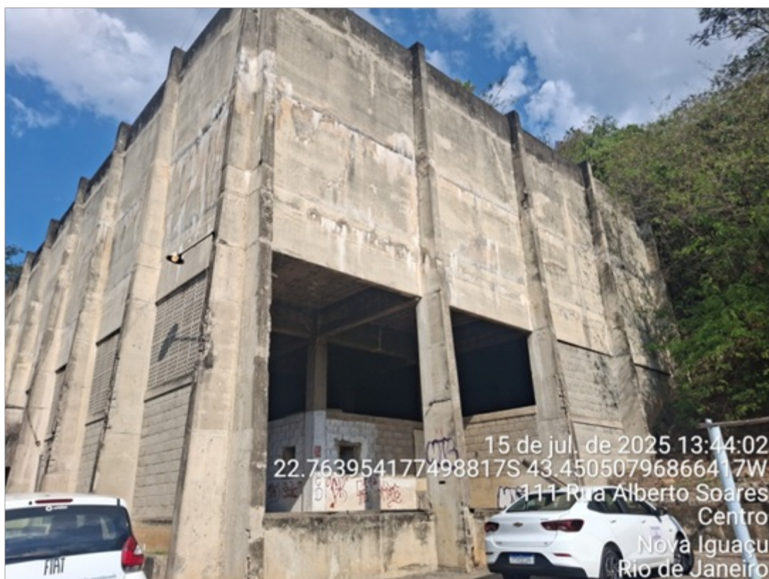
Foto 2 – Fachada principal reservatório
