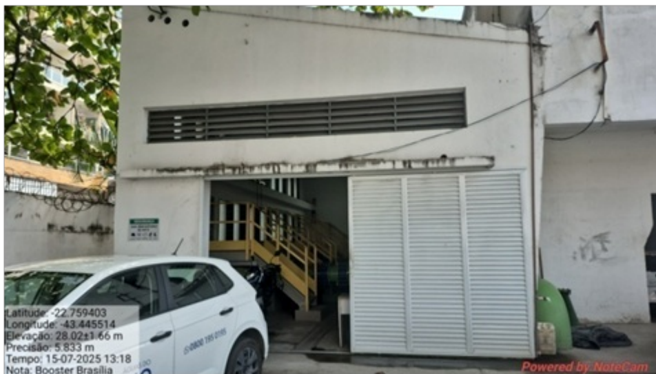
Foto 1 – Abrigo booster (ou elevatória)
