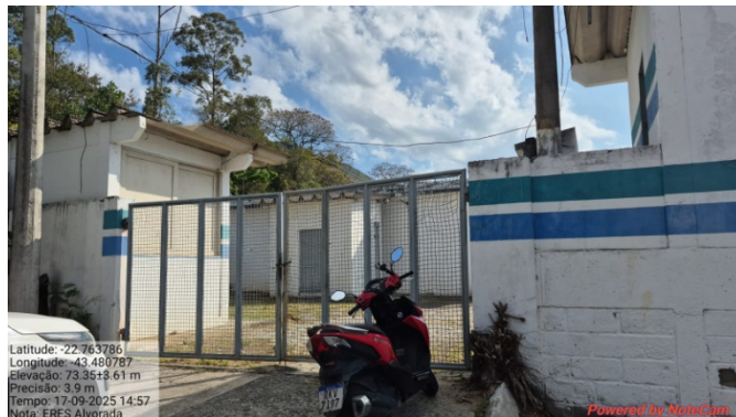
Foto 1 – Portão de acesso ao reservatório
