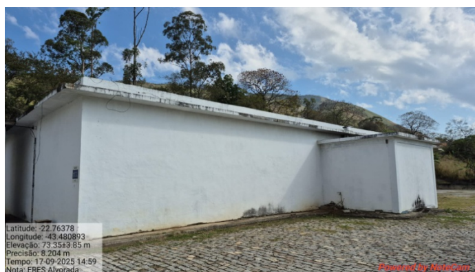
Foto 3 – Fachada principal reservatório
