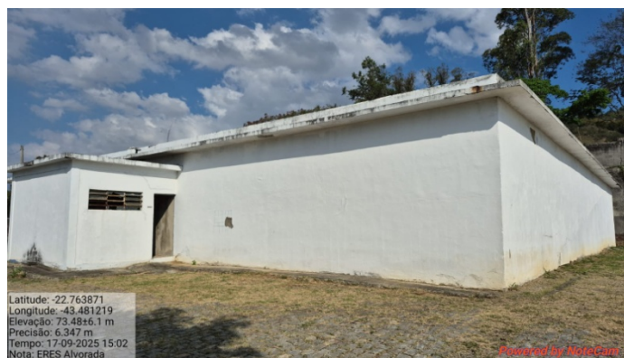
Foto 4 – Parte fachada lateral e acesso ao barrilete
