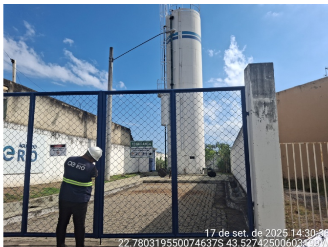
Foto 1 – Acesso ao reservatório
