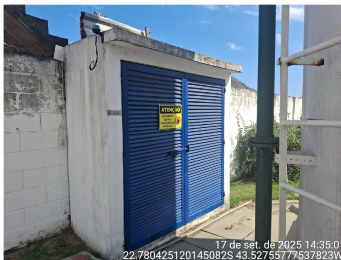
Foto 5 – Abrigo para painéis e edificação operacional
