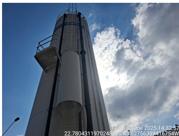
Foto 2 – Fachada principal reservatório
