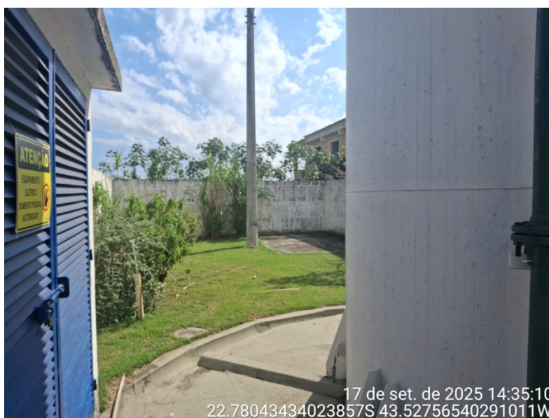
Foto 8 – Painéis de comando
