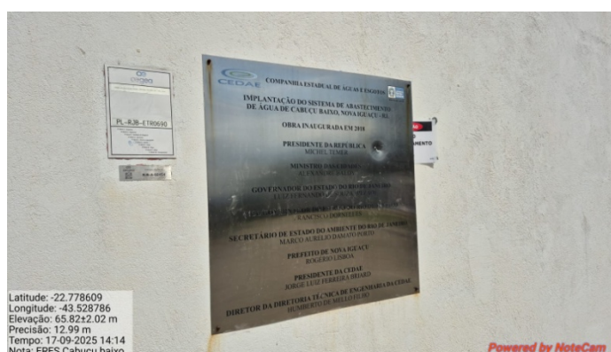
Foto 3 – Fachada principal reservatório
