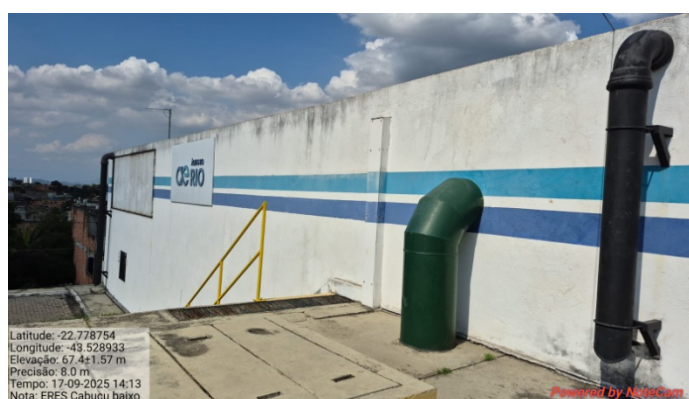
Foto 2 – Fachada principal reservatório
