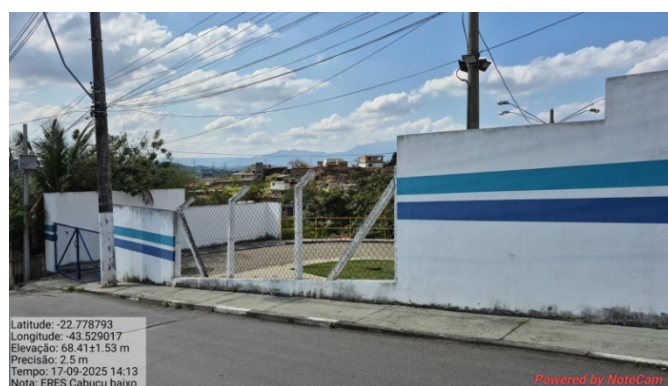
Foto 1 – Acesso ao reservatório
