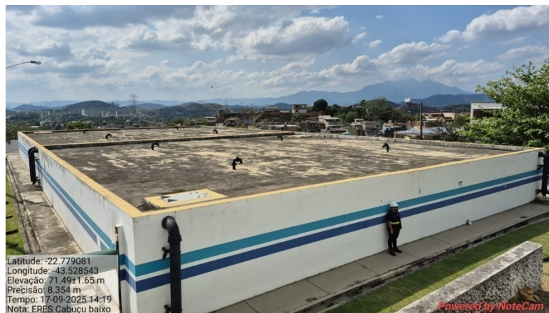
Foto 9 – Laje do reservatório
