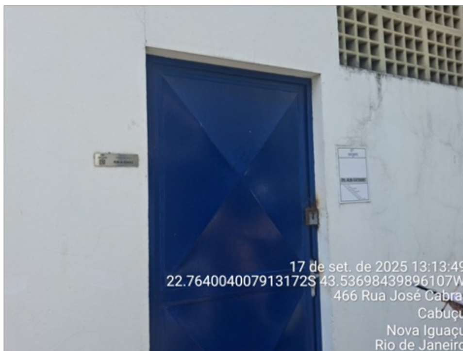
Foto 2 – Porta de acesso ao abrigo, placa do bem
