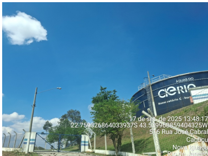
Foto 1 – Acesso ao reservatório
