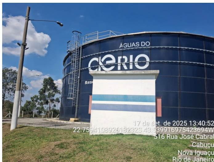
Foto 2 – Fachada principal reservatório
