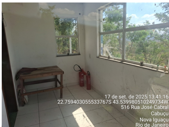
Foto 8 – Interior edificação operacional
