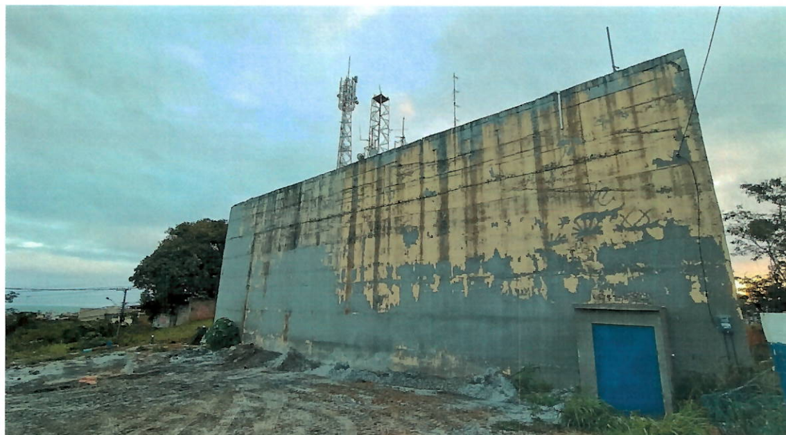
Foto 2: Vista frontal do reservatório.
