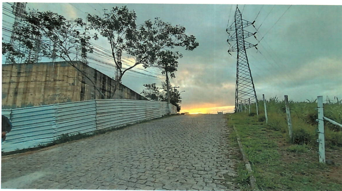
Foto 4 : Área do reservatório cercada.
