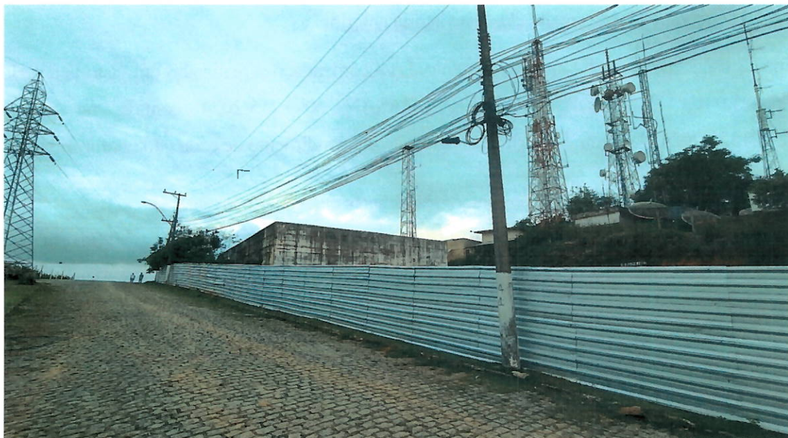
Foto 5 : Área do reservatório cercada.
