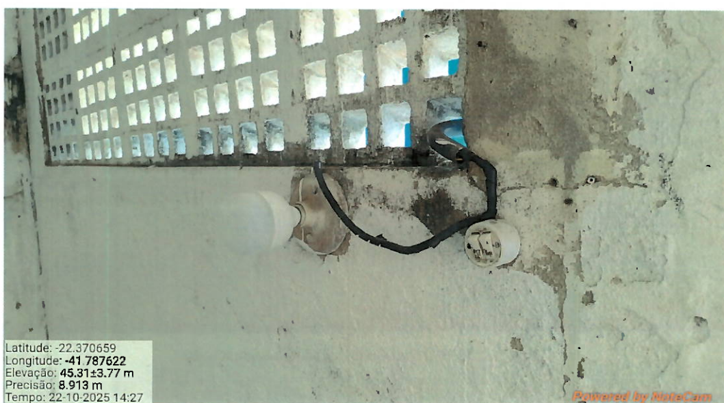
Foto 20: Adequação elétrica realizada solicitada em vistoria anterior.
