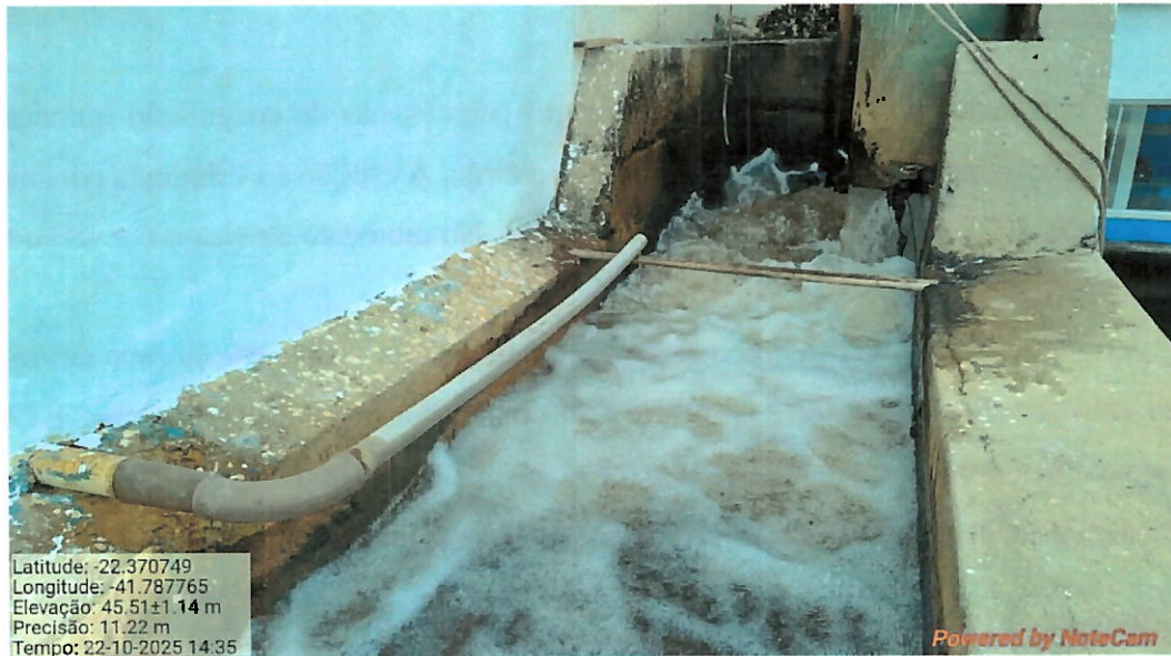
Foto 6: Entrada de água bruta na VETA com ponto de aplicação de coagulante sulfato de alumínio
