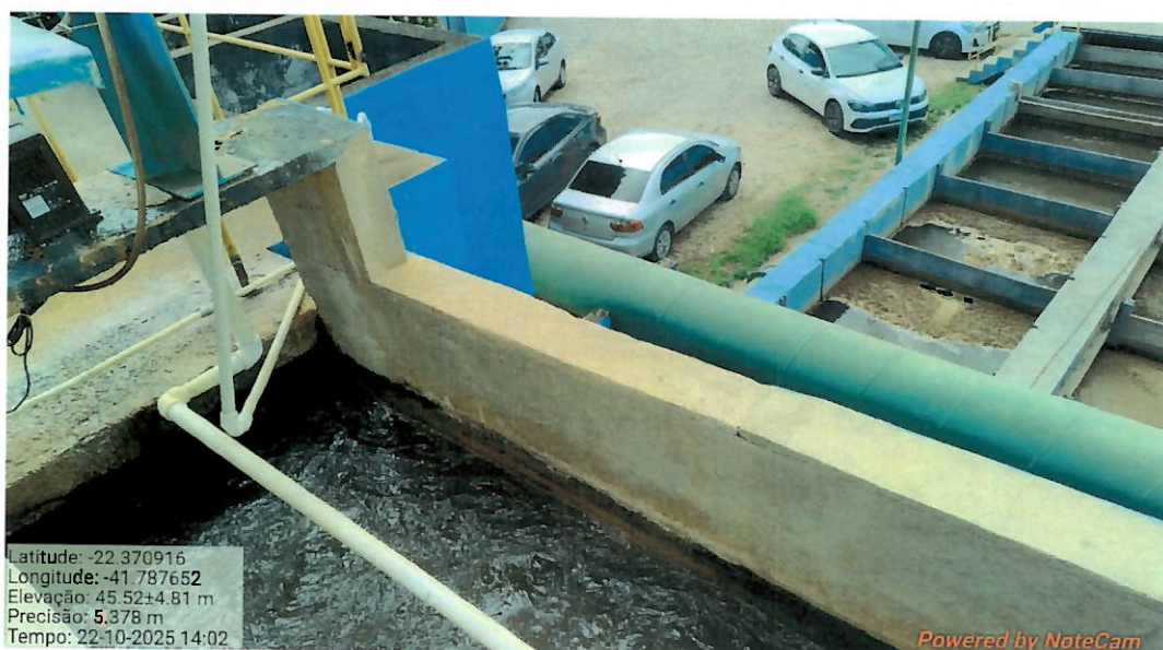
Foto 9: Estrutura de concreto reparada em atendimento a solicitação feita em vistoria anterior (NETA).
