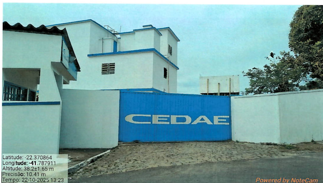
Foto 1: Fachada da ETA.
