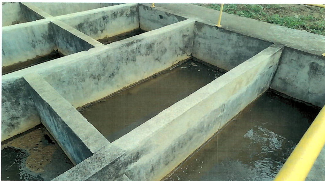
Foto 12: Estrutura de concreto reformada na NETA em atendimento a solicitação feita em vistoria anterior.
