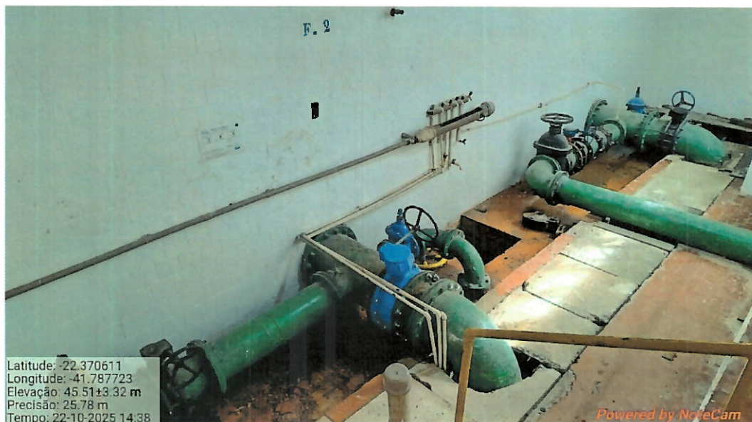
Foto 23: Casa de válvulas dos filtros 2 e 1.
