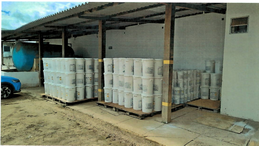
Foto 37: Armazenamento de hipoclorito de cálcio.
