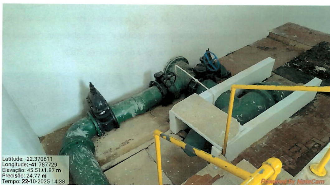
Foto 22: Casa de válvulas dos filtro3.
