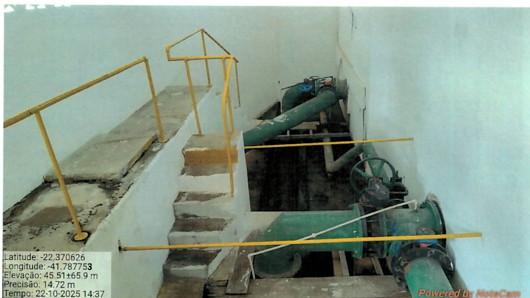
Foto 21: Casa de válvulas dos filtros 4 e 5.
