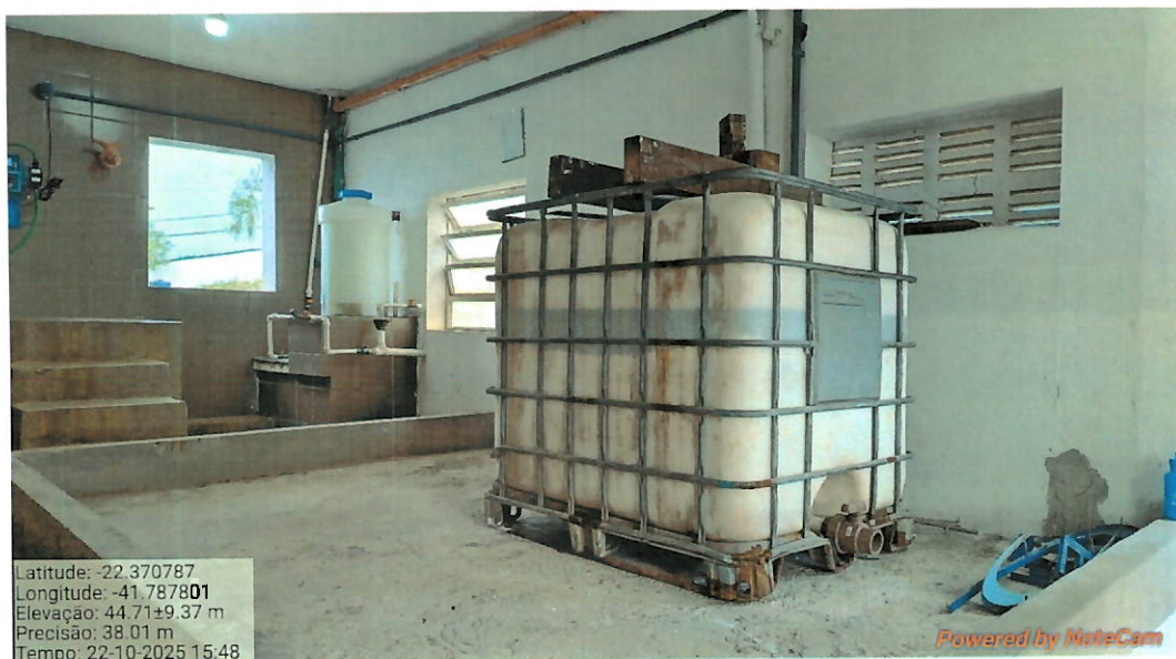
Foto 36: Armazenamento de hidróxido de cálcio em suspensão sobre bacia de contenção.
