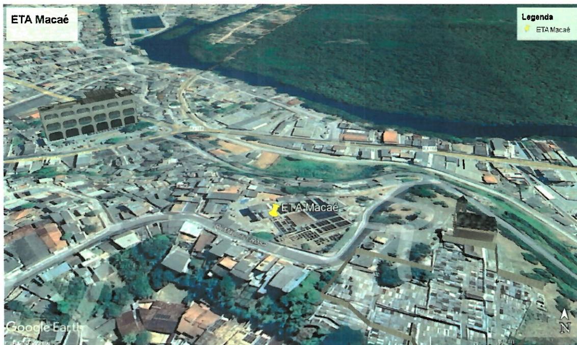
Imagem 1: Localização da ETA Macaé (22°22'14.95"S 41°47'16.08"O).
